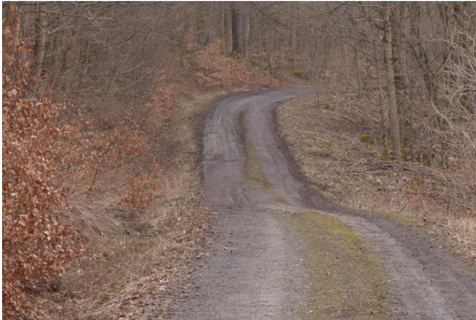
Abb. 18: Die Eindellung einer Forststraße im Bereich einer flachgründigen Rutschung südlich des Kreuzberges weist auf jüngere Bewegungen innerhalb der Rutschung hin.
