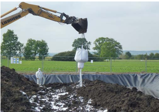
Abb. 6: Zugabe von NaOH zum mit RDX kontaminierten Bodenmaterial (ehem. SP Marktbergel, 2014)
