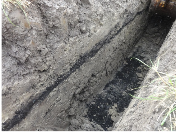
Abb. 5: In einem Baggerschurf ist der lageweise Einbau der Kompostschichten zu erkennen (ehem. SP Marktbergel).
