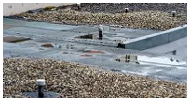
Abb. 5: Schwerpunkt Baustoffe: mit Dachpappe verkleidetes Flachdach mit Regengallen
