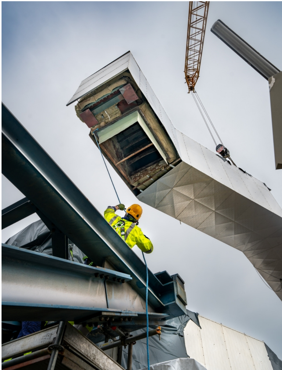
Abb. 9: Rauchgaswäscher- tausch, Montage Rauchgaskanal GSB Baar-Ebenhausen
