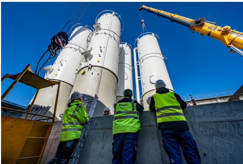
Abb. 1: Aufstellung des neuen Tanklager IV bei der GSB Baar-Ebenhausen
