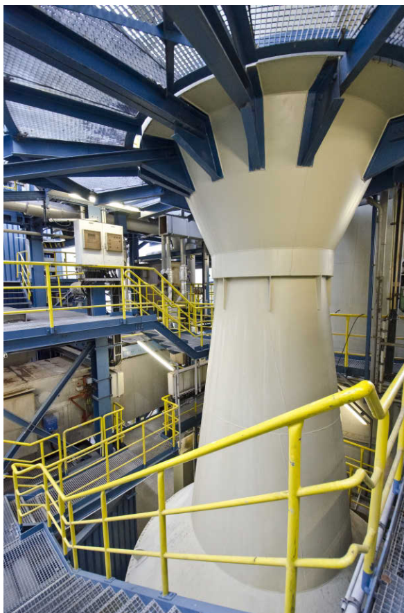
Abb. 5: Abluftreinigung bei der GSB in Baar-Ebenhau- sen
