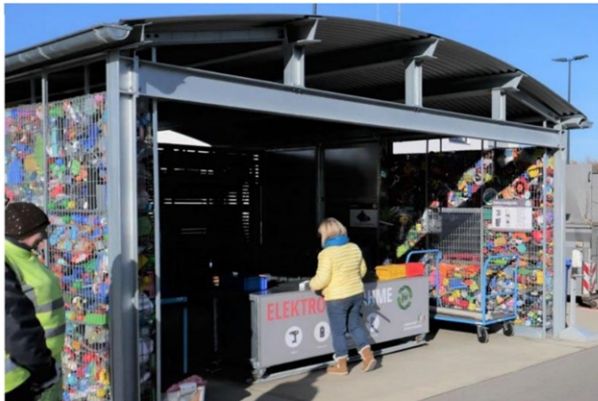
Neue überdachte Annahme für Elektro- und Elektronikaltgeräte mit Übergabetisch am Wertstoffhof Dasing, Landkreis Aichach-Friedberg
