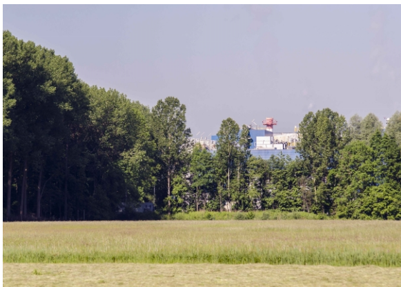
Abb. 3: GSB-Verbrennungslinie 3 in Baar-Ebenhausen
