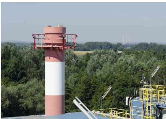
Abb. 5: Reinigungskamin bei der GSB in Baar-Ebenhausen
