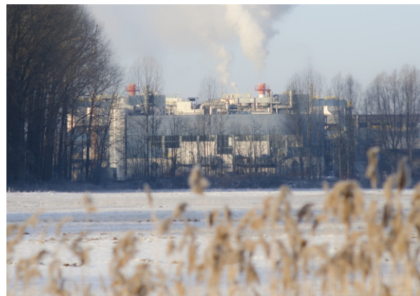
Abb. 4: Sonderabfallverbrennungsanlage der GSB in Baar-Ebenhausen
