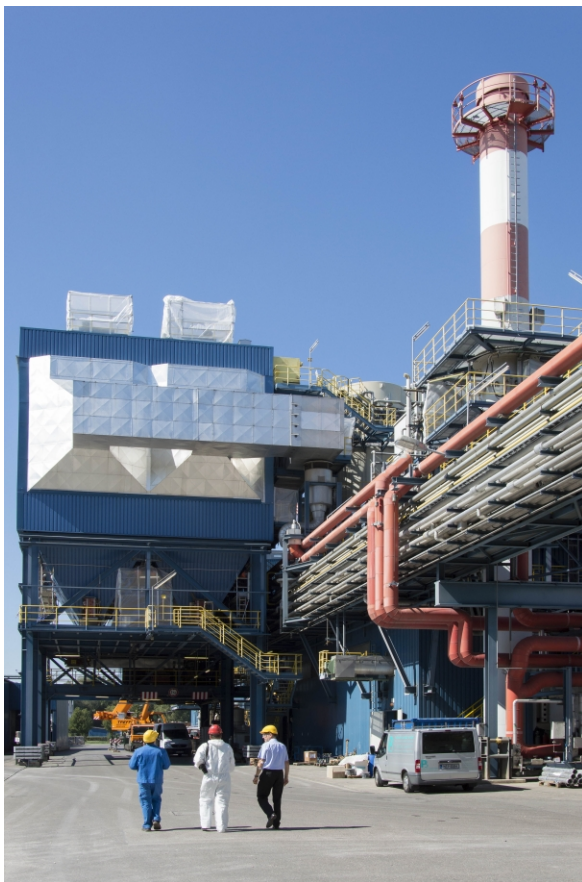
Abb. 16: Sonderabfall-Verbrennungsanlage der GSB in Baar-Ebenhausen
