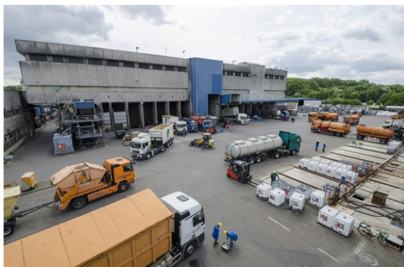
Abb. 9: Anlieferungsbereich bei der GSB in Baar-Ebenhausen
