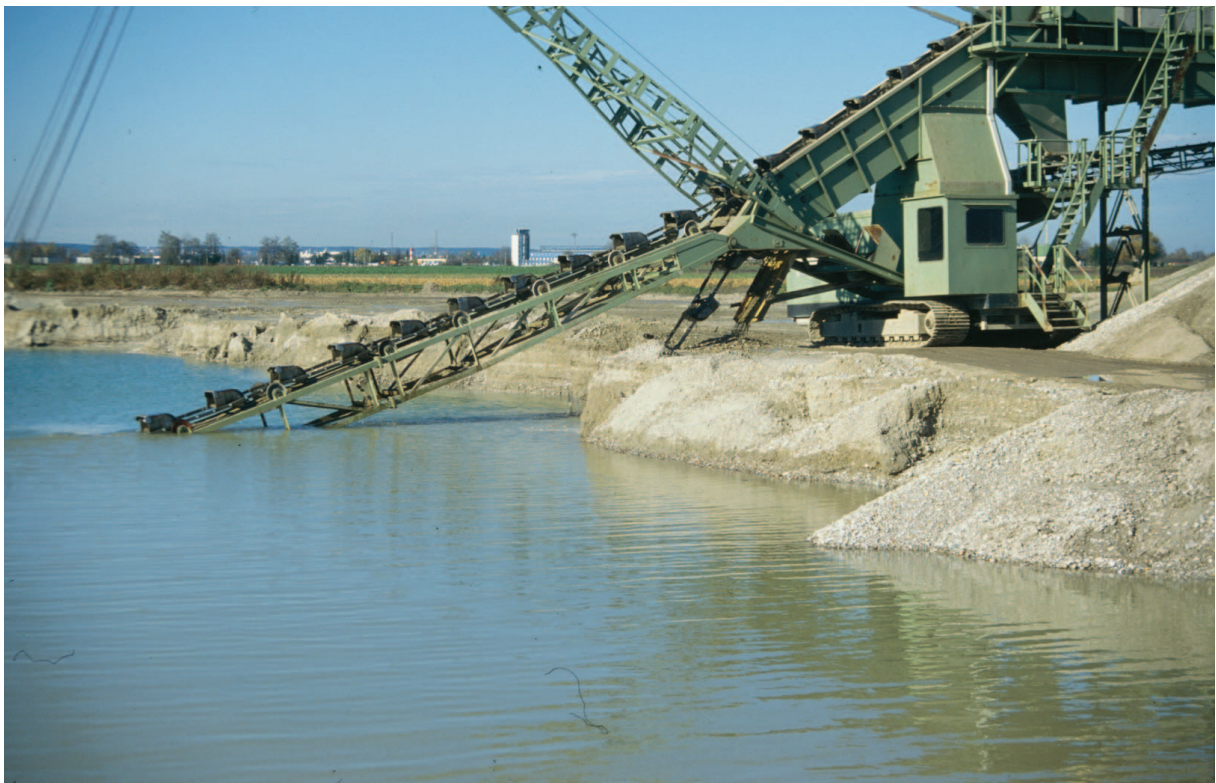
Abb. 27: Donauquartär bei Ingolstadt – Kiesabbau mit Grundwasserfreilegung
