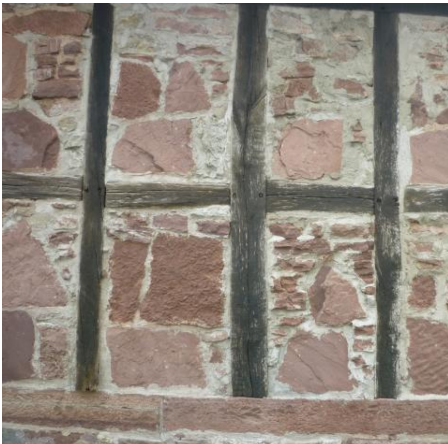
Abb. 6: Fachwerk an einem ehemaligen Gaden der aufgelassenen Kirchenburg in Fuchstadt. Der früher verwendete Lehm wurde im Rahmen musealer Restauration durch Bruchsteine aus Buntsandstein, im wesentlichen Plattensandstein (so2PS), ersetzt, die den Geologen wegen ihres Gefüge-Reichtums anziehen.
