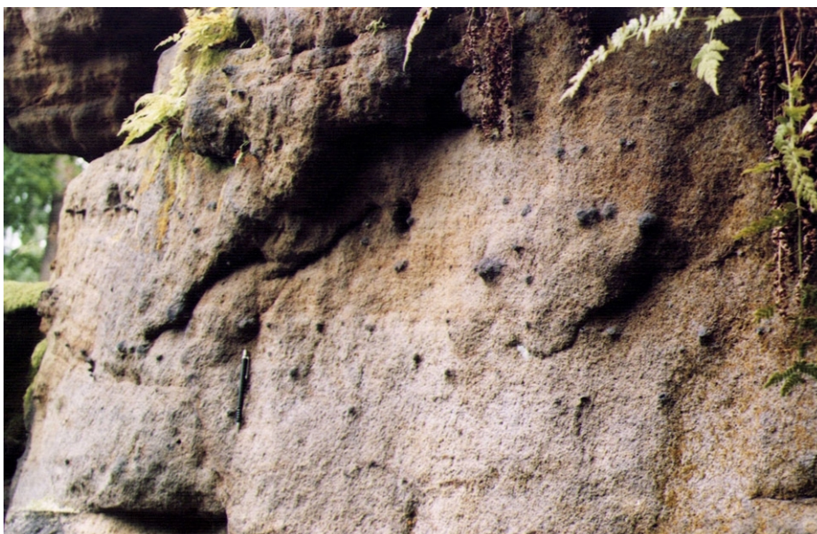
Abb. 9: Herausgewitterte limonitisch-konkretionäre Bereiche im Hauptsandstein (Haßwald Nord)
