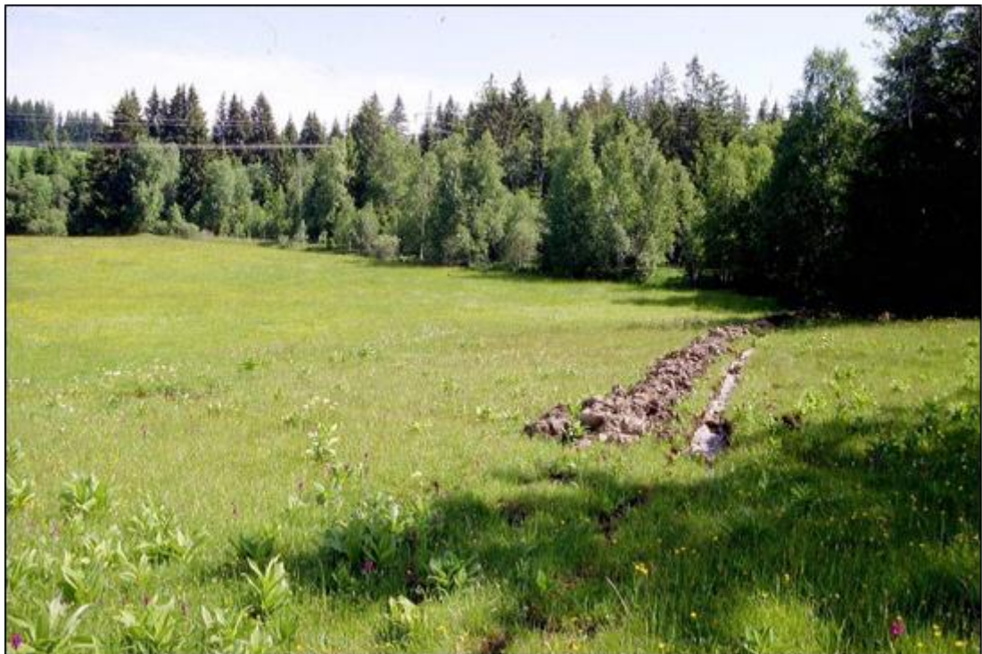
Abbildung 26: Frisch ausgehobener Entwässerungsgraben in der Untersuchungsfläche B (Foto: F. Gnoth-Austen)
