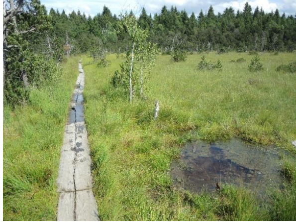
Abbildung 50: Trittschäden am Rand des „Brettleweg“ Gegenverkehr oder Abschnitte mit beschädigter Stegkonstruktion verleiten zum Ausweichen. Entlang des Steges kommen zerstreut Störungszeiger wie Flatterbinse vor.
