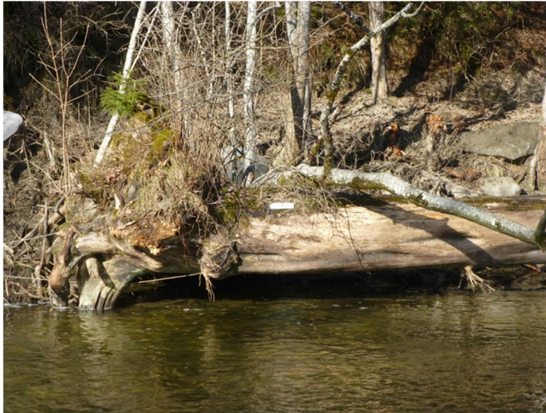
Abbildung 5: Mit Stahlseil verankertes Totholz in der Wertach (Foto: E. Pfau, AELF Ansbach)
