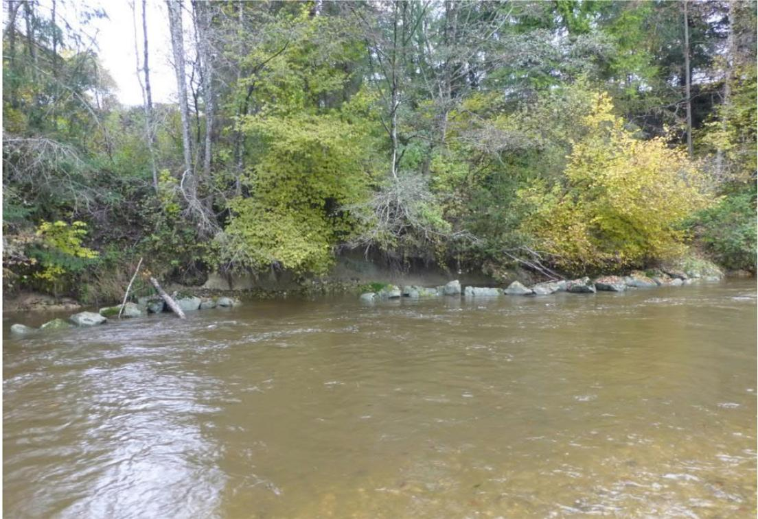
Abbildung 30: Uferbefestigung an der Wertach – vom Wasser unterspült (Foto: E. Pfau, A-ELF Ansbach)
