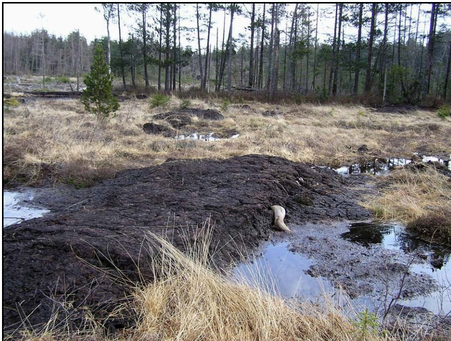
Abbildung 14: Grabenanstau mit Hochmoortorf im nördlichen Breitmoos (Foto: B. Mittermeier, AELF Krumbach)
