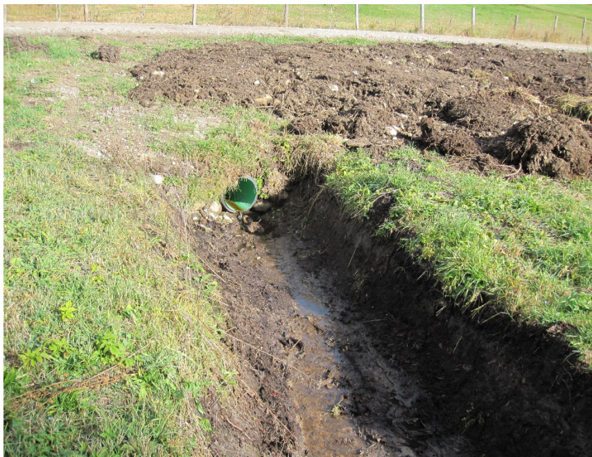
Abb. 27: Verbreiterung und Vertiefung von Entwässerungsgräben in einer Pfeifengraswiese im Schildschwaiger Filz 2018 (Foto: Anderlik-Wesinger)
