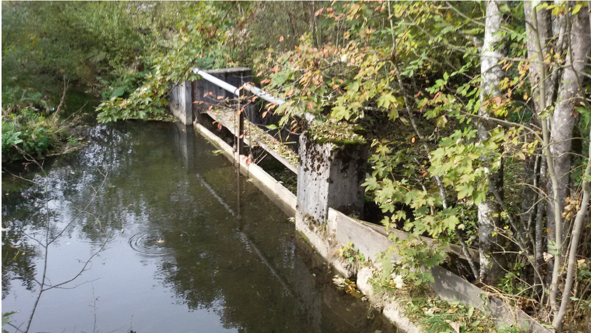
Abb. 24: Aufstau, Ausleitung und Absturz südlich Schildschwaig (Foto: Anderlik-Wesinger)
