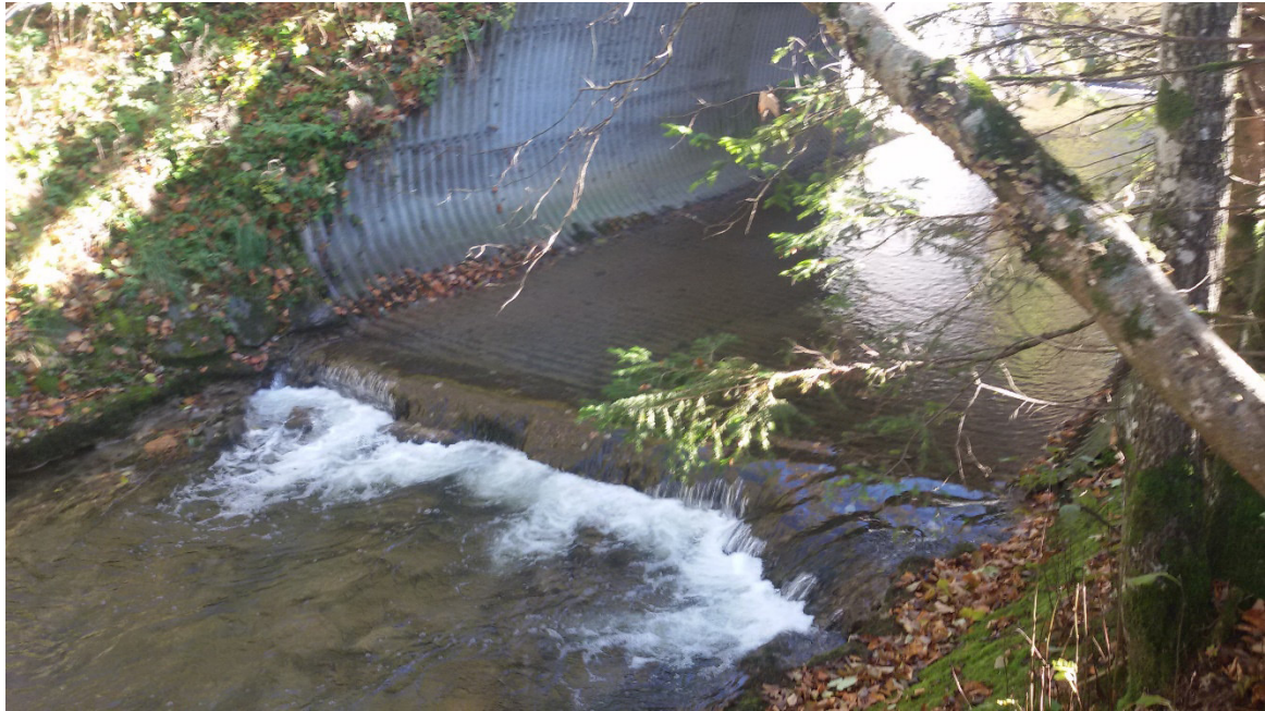
Abb. 22: Brücke mit Sohlsicherung und Absturz (Foto: Anderlik-Wesinger)
