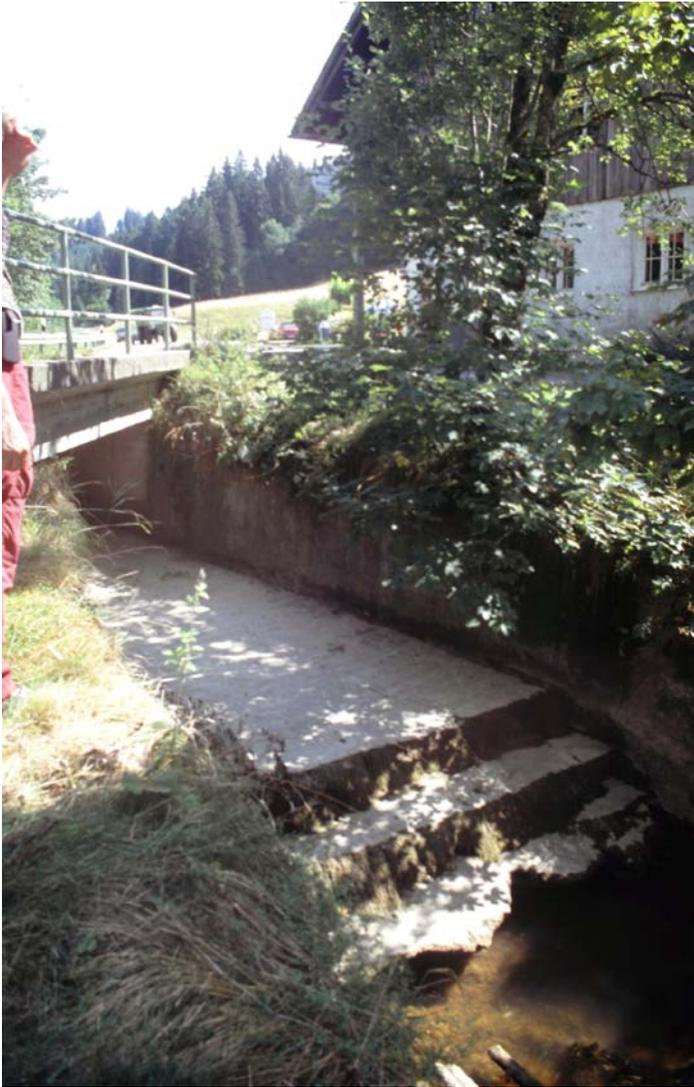
**Bild 6: oben Gefährdung der Fischfauna durch „Fischfalle“: Betonkasten an Straßenunterführung der Kürnach mit Auskolkung im Absturzbereich (Foto: ARGE Waldökologie)**
