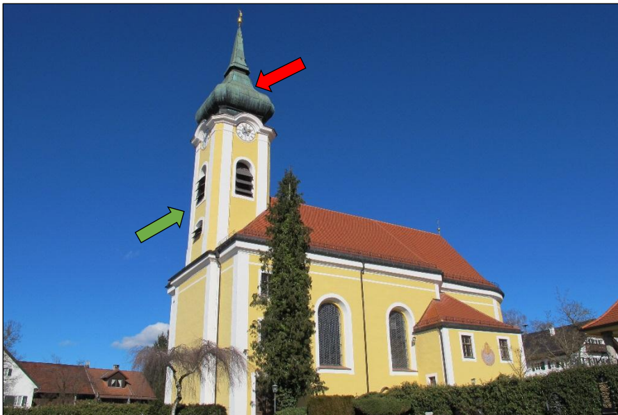
Abb. 2.2.4 – 2: Außenansicht der Kirche mit Hangplatz (roter Pfeil) und den Spalten an den Schallluken als Ausflugsöffnungen (grüner Pfeil, Bildquelle: Geiger-Udod)
