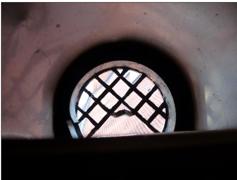
Abb. 2.2.2 – 4: Großes Mausohr - Detail des Lüfterziegels, nur relativ wenige Nutzungsspuren vorhanden
