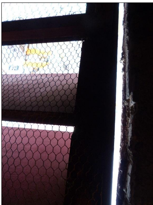
Abb. 2.2.1 – 5: Die Schallluken sind weitestgehend mit Hasendraht verschlossen und weisen nur randlich schmale Spalten auf
