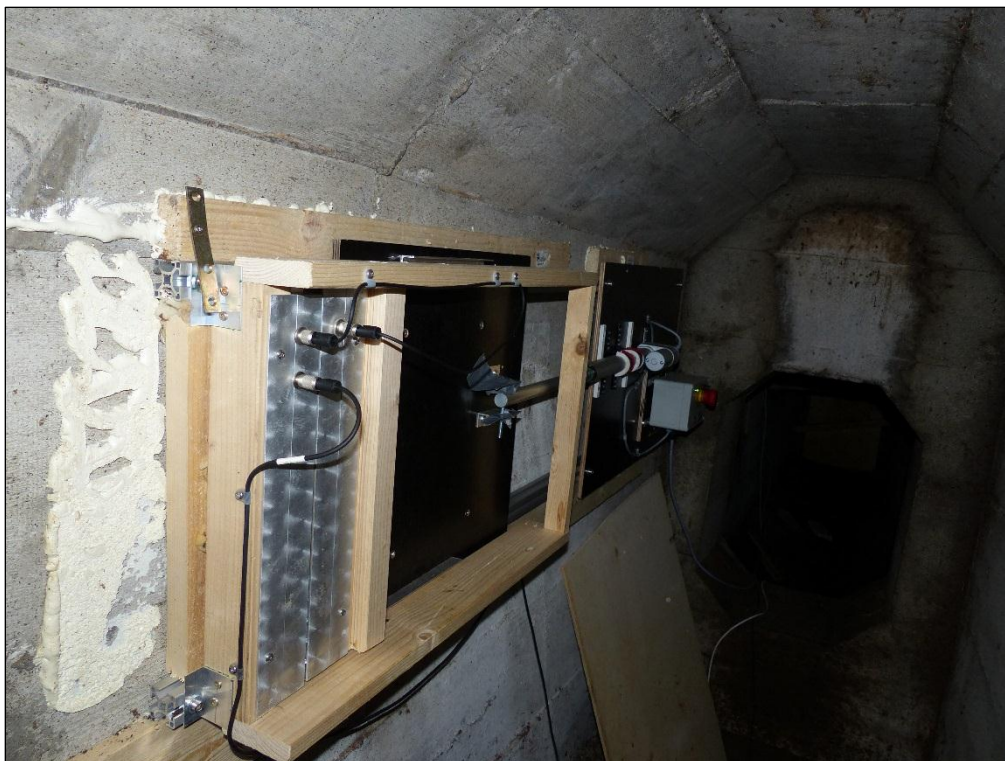
Abb. 2.2.6 – 3: Traditionell genutzte Ausflugsöffnung, mit technischer Lösung zum Öffnen und Verschließen über Internet ausgestattet
