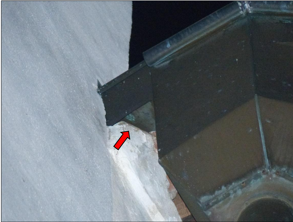
Abb. 2.2.5 – 4: Detailansicht des Einfluges hinter der Dachrinne an der Feuerschutzwand, Zugang bis zur Öffnung muss vermutlich krabbelnd erfolgen
