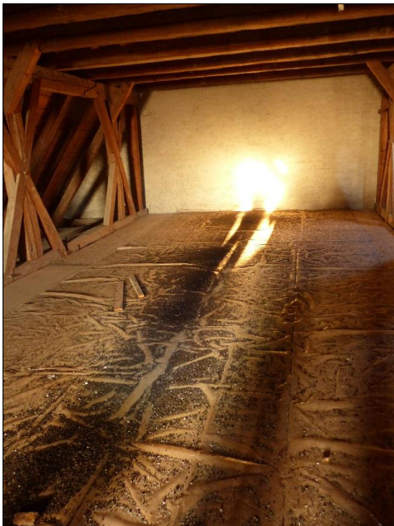
Abb. 2.2.5 – 5: Provisorisch abgedeckter Hangplatz hinter dem runden Einflugsfenster, helle Beleuchtung durch Abendsonne
