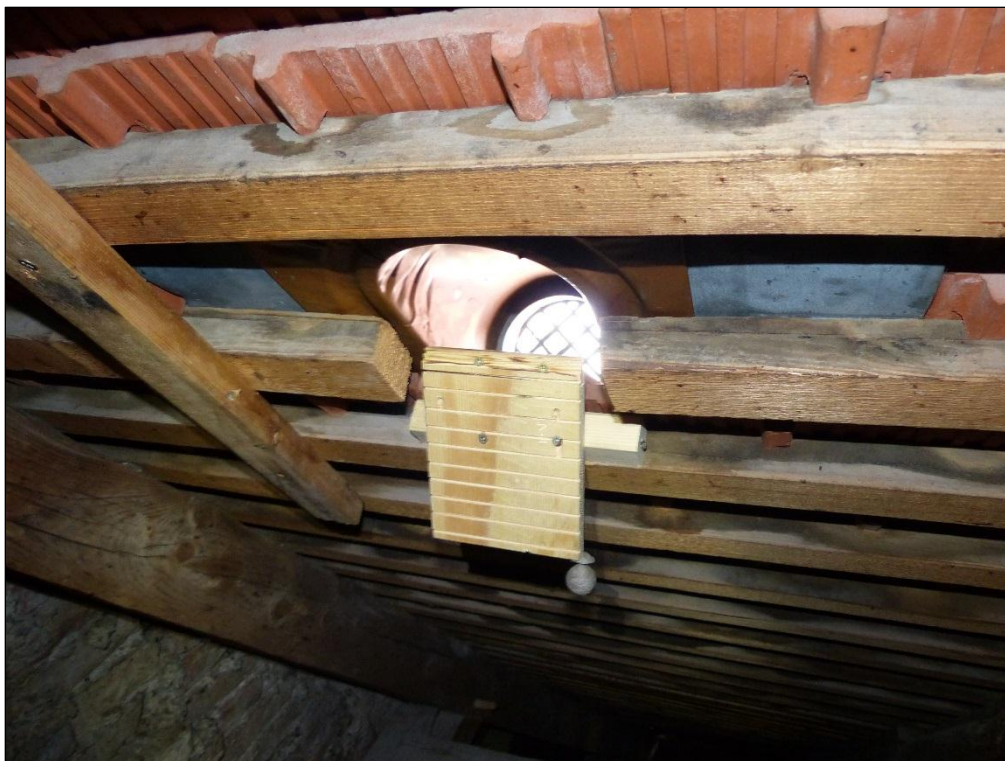
Abb. 2.2.2 – 3: Großes Mausohr - vermutlich für Fledermäuse optimierter Lüfterziegel nach Norden
