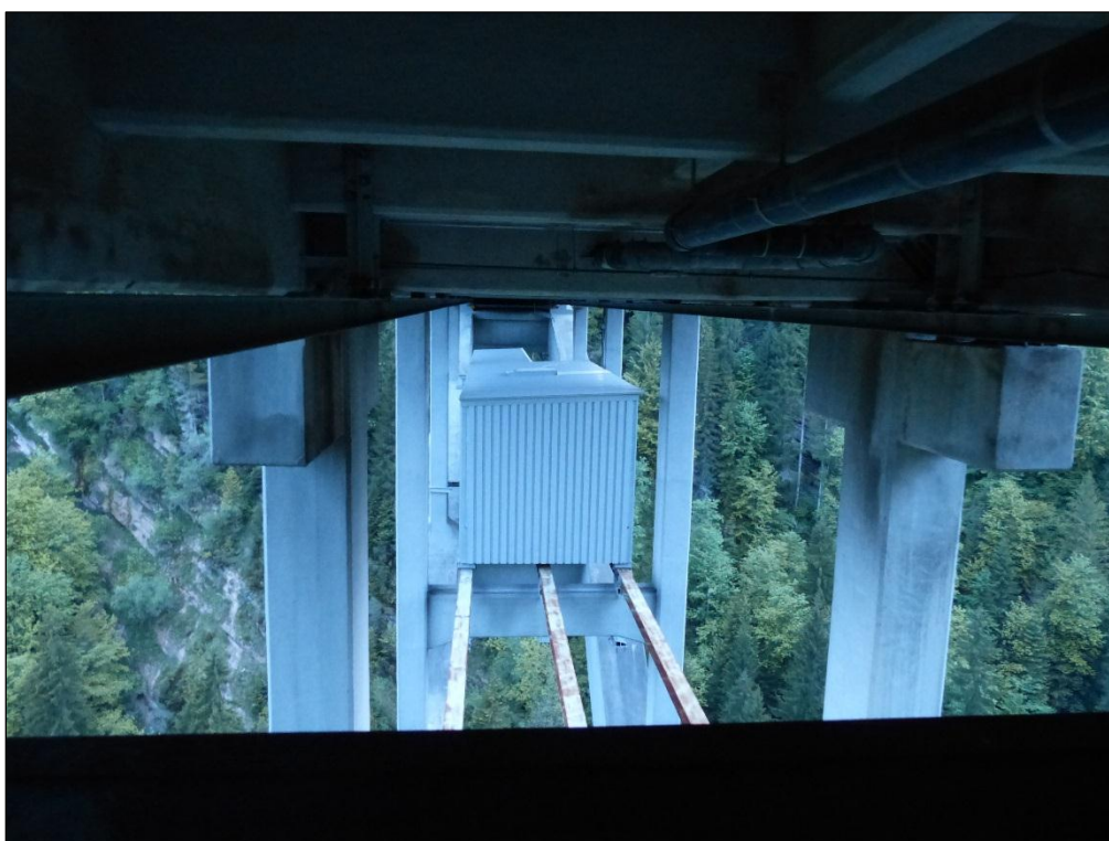
Abb. 2.2.6 – 4: Außenansicht des Ersatzquartiers unterhalb der Brücke
