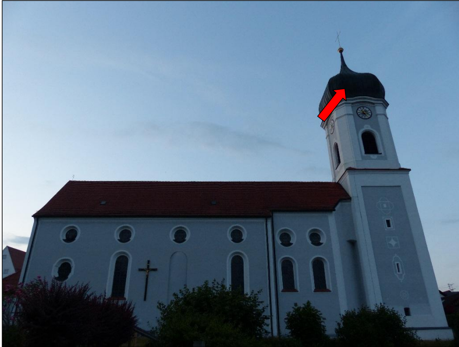
Abb. 2.2.1 – 2: Außenansicht der Kirche von Süden, der Pfeil zeigt den Hangplatz in der Zwiebel des Turmes
