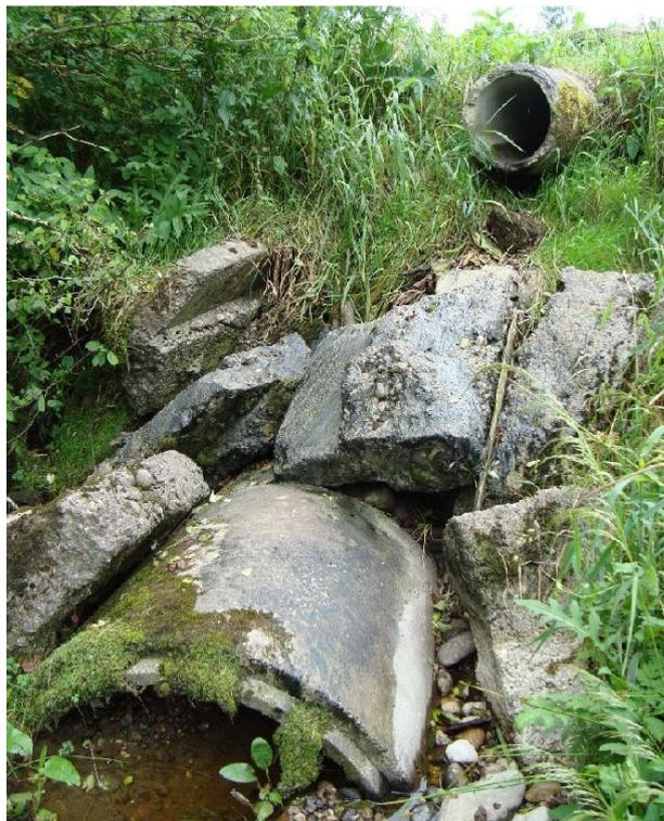
Abb. 28: Beispiel einer nicht passierbaren Verrohrung unter einer Forststraße am Herrenwiesgraben, Foto: C. Berger
