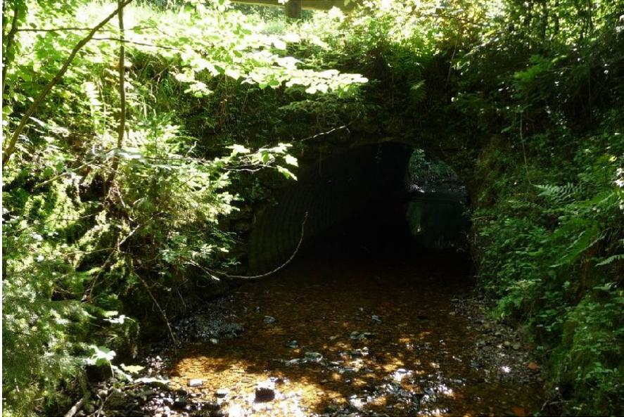
Abb. 27: Barrierefreie Verrohrung unter einer Straße (Großer Rabenbach bei Rabenbach), Foto: C. Berger
