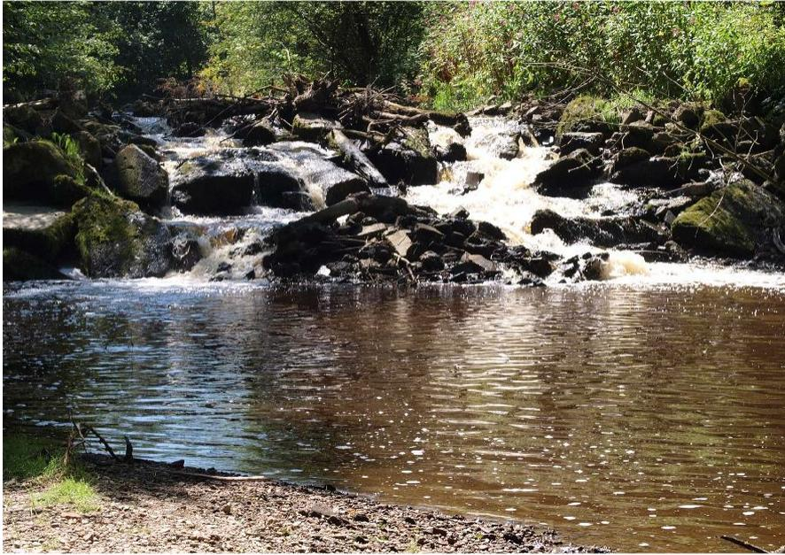
Abb. 29: zu steile Sohlschwelle der Rott bei Zoss, Foto: H. Schmidt
