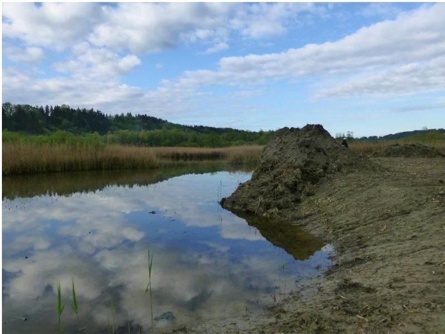
Abbildung 9: Freihamer Au: Altarmvertiefung und –erweiterung mit Teilanbindung an den Inn - kleinflächige Strukturverbesserungsmaßnahmen in den Wintern 2010/11 und 2012/13 haben wieder Teile der Altwässer an den Fluss angeschlossen. Neue Auflandungen können sich offenbar nur noch vor der Freihamer Au bilden. Der Rest der Ufer ist steil und dammartig (auch in den Auen).
