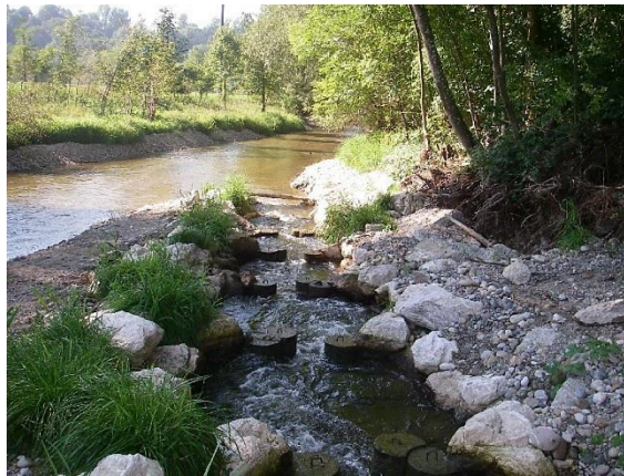
Abb. 29: Anbindung der Fischwanderhilfe an die Mindestwasserstrecke im Bereich Mühltal (Foto: Dr. M. Holzner)
