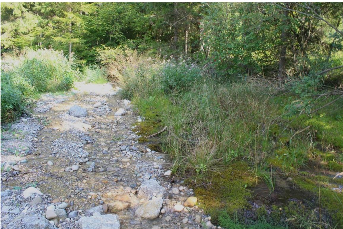
**Abb. 33:** Regenerationsmaßnahme zu diesem Tuff-Quellbach durch Anhebung der Bachsohle. Es erfolgte Wiederanhebung des Bachgerinnes auf die ursprüngliche Sohlhöhe durch Auffüllung des neu geschaffenen Bagger-Grabens durch Auffüllung mit kiesig-bindigem Material. Die von der Aus-
