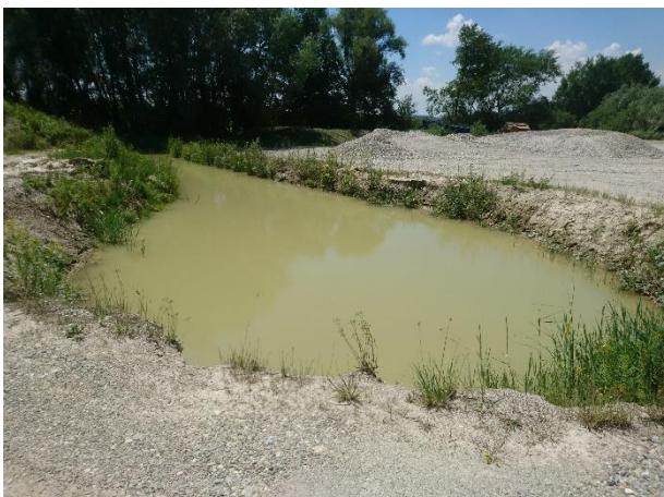
Abbildung 28: Sedimentabsetzbecken (Foto: U. Geise)
