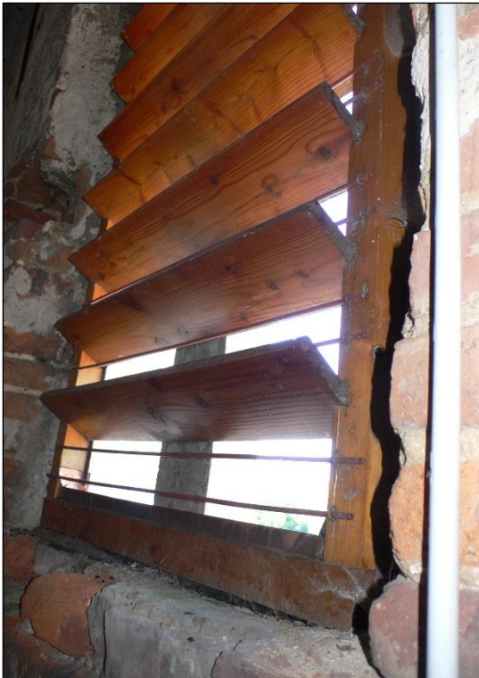
Abb. 2.2.1 – 3: Gitterstäbe an den Öffnungen der Schallluken zur Taubenabwehr, für die Mausohren stellen diese keine erhebliche Beeinträchtigung dar, Bildquelle: Fr. Hager
