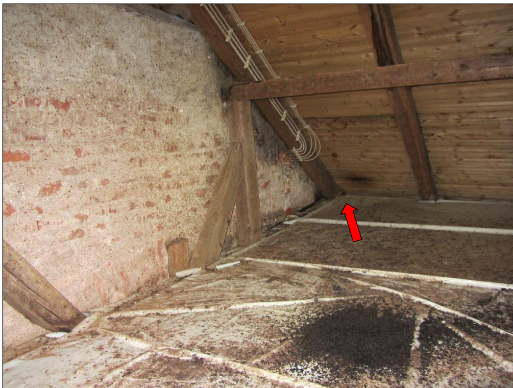
Abb. 2.2.7 – 4: Quartier über der Sakristei – Innenraum unter dem Haupthangplatz, in der Ecke befindet sich der Ausflug
