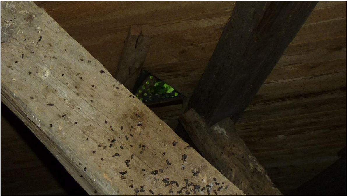
Abb. 2.2.5 – 3: Ausflugsöffnung in der Turmspitze von innen. (Foto: Lustig)
