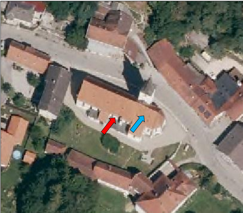
Abb. 2.2.1 – 1: Luftaufnahme der Pfarrkirche in Zeilarn mit Haupthangplatz im Dachstuhl (roter Pfeil) und Ausflugsöffnung (blauer Pfeil)
