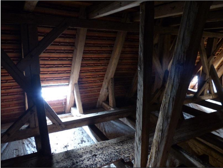
Abb. 2.2.1 – 7: Der Dachboden ist durch mehrere Fenster generell eher hell
