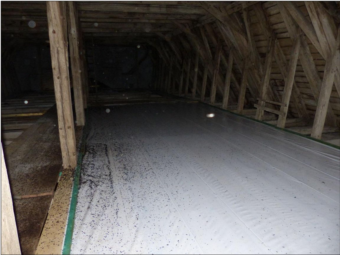
Abb. 2.2.3 – 8: Ausgebesserter Zwischenboden mit Folie als Schutz vor Fledermauskot im Dachboden
