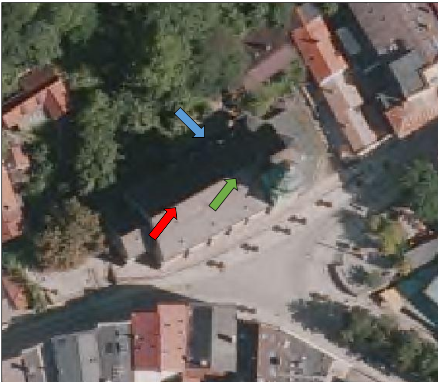
Abb. 2.2.3 – 1: Luftaufnahme der Kirche „Sankt Andreas“ in Trostberg mit den Hauptangplätzen von Mausohr (roter Pfeil) bzw. Wimperfledermaus (grüner Pfeil) im Dachstuhl und der gemeinsamen Ausflugsöffnung auf der Nordseite (blauer Pfeil)
