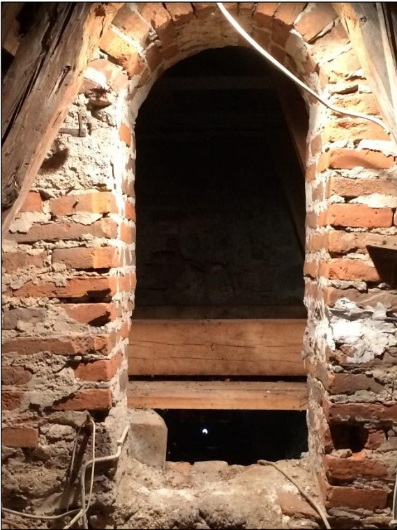
Abb. 2.2.6 – 3: Durchflug zwischen Turm und Dachboden (Hinweisschild auf der Rückseite)
