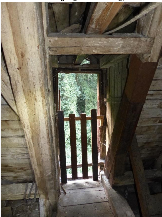
Abb. 2.2.3 – 5: Ausflug über eine Öffnung für einen Lastenzug auf der Nordseite
