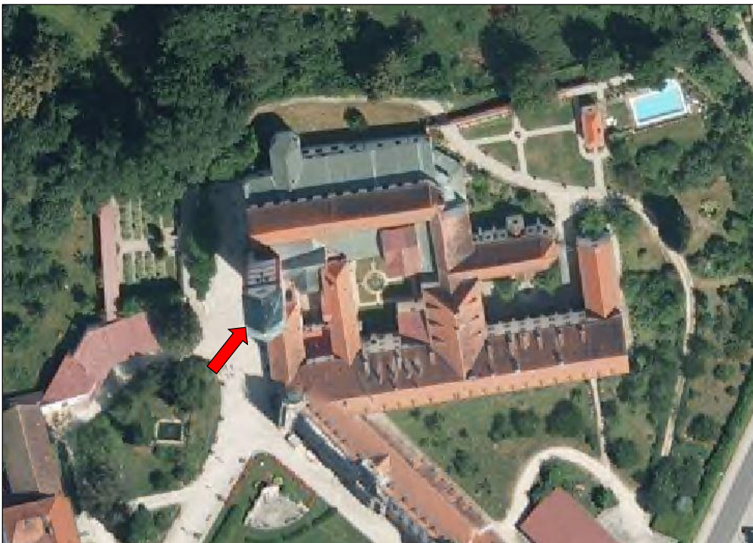
Abb. 2.2.5 – 1: Luftaufnahme des Klosters Scheyern, Hangplatz mit rotem Pfeil markiert Bildquelle: Geobasisdaten des Bayerischen Landesvermessungsamtes, http://www.geodaten.bayern.de , Nutzungserlaubnis vom 6.12.2000, AZ.: VM 3860 B – 4562.
