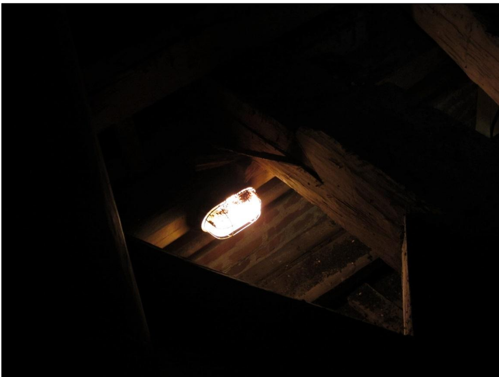
Abb. 2.2.7 – 7: Turm – Beleuchtung der Luke zu den Ausflugsöffnungen
