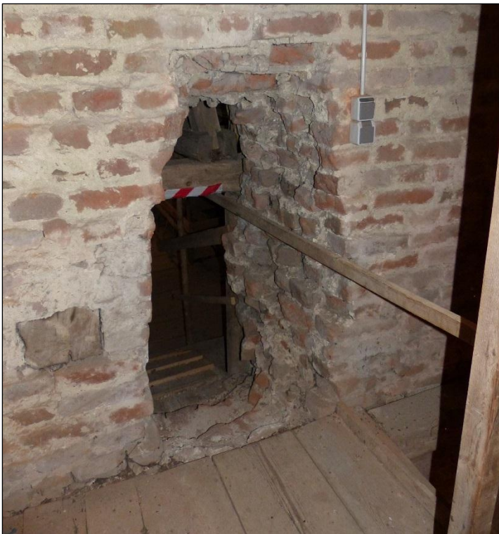
Abb. 2.2.1 – 5: Durchflug zwischen Hangplatz und Ausflug, hier wurde der Einbau einer Feuerschutz- türe diskutiert
