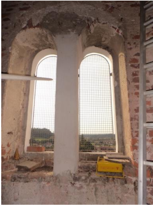
Abbildung 3: Schallöffnungen mit Spalten (Foto: Brigitte Kraft )
