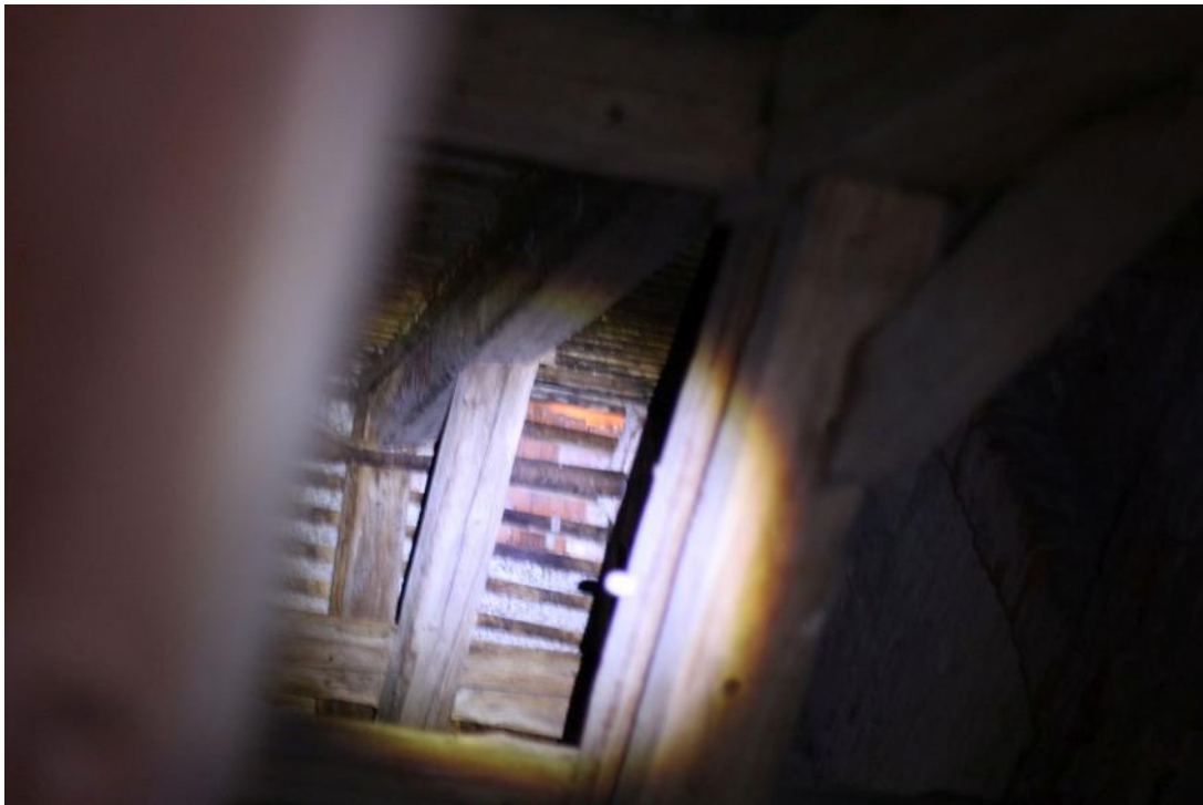
Abbildung 16: Ein- bzw. Ausflugsmöglichkeit durch defekten Firstziegel auf der Westseite (Foto: Fritz Ebelt)
