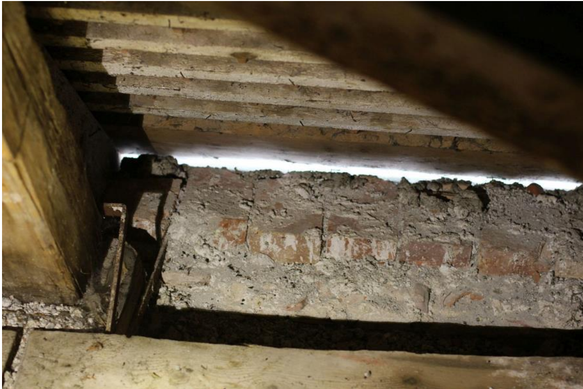
Abbildung 17: Ein- bzw. Ausflugsmöglichkeit durch Spalt im Traufbereich im Norden des Chordachstuhles (Foto: Fritz Ebel)
