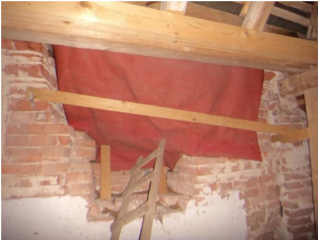
Abbildung 9: Dachraumteilung mittels Stoff (Foto: Brigitte Kraft)
