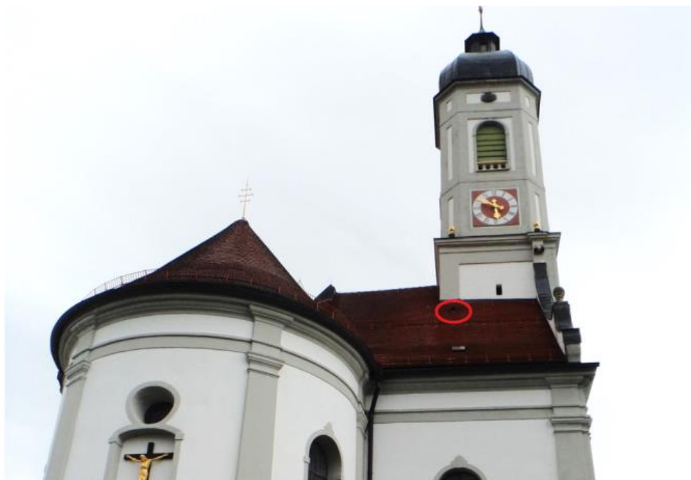
Abbildung 13: Ein- bzw. Ausflugsmöglichkeit durch eingebauten Dachziegel auf der Ostseite (Foto: Brigitte Kraft)
