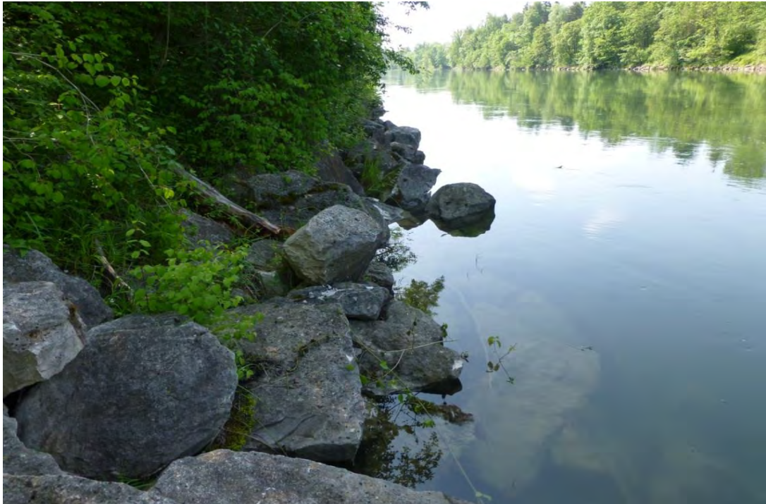
Abbildung 44: Das Ufer am Lech ist auf weiten Strecken für den Biber nicht grabbar (Foto: E. Pfau, AELF Ansbach).
