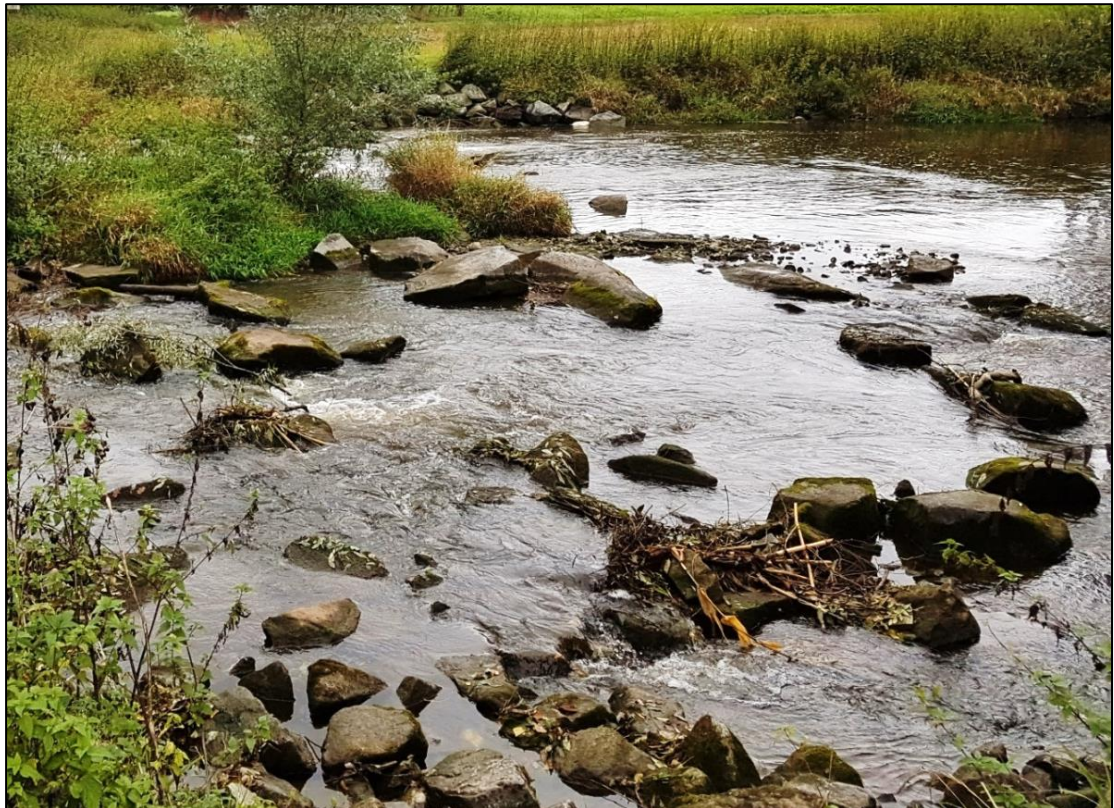
Abb. 13: In der Unteren Rott finden sich mehrere Rampen aus Wasserbausteinen.
