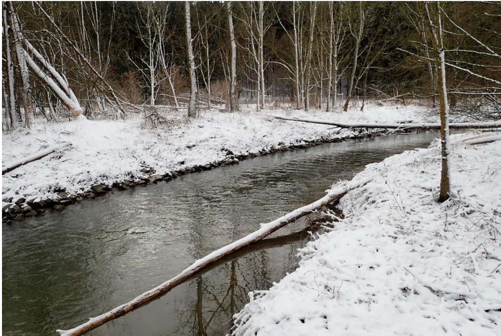
Abb. 14: Steinschüttung am Prallhang der kleinen Vils bei Lichtenhaag
