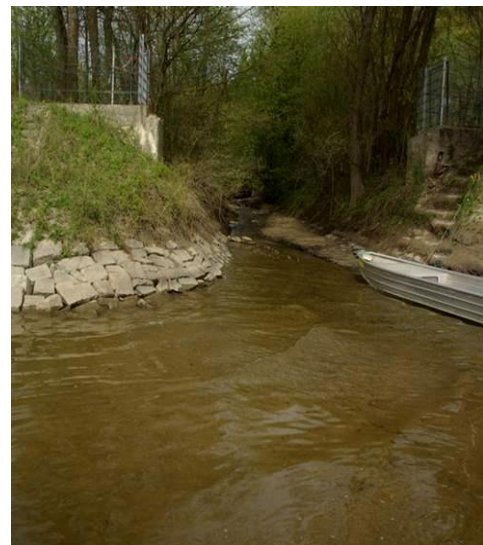
Abbildung 93: Strukturtypen im Bereich der Maßnahme - Hafen mit durchgehender Blockwurfstruktur bei Lindau mit Bachmündung.
