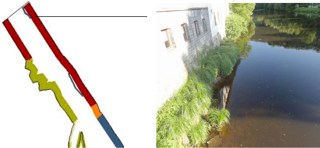
Abbildung 47: Strukturtypen im Bereich der Maßnahmen, lotrechte Mauer mit vorgelagerten Strukturen, unterhalb der Brücke.
