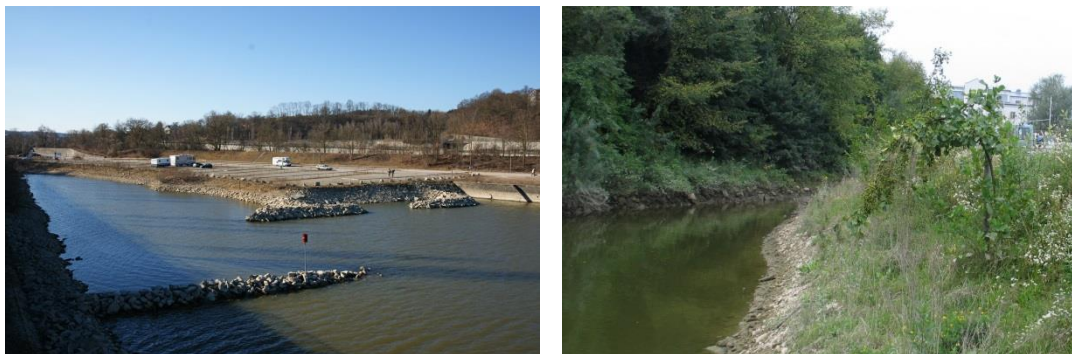
Abbildung 22: Linkes Bild: Umgesetzte Ausgleichsmaßnahmen im Betriebshafen Rackelau, Kurzbuhnen und Langbuhne; Rechtes Bild: flach auslaufender Uferbereich
