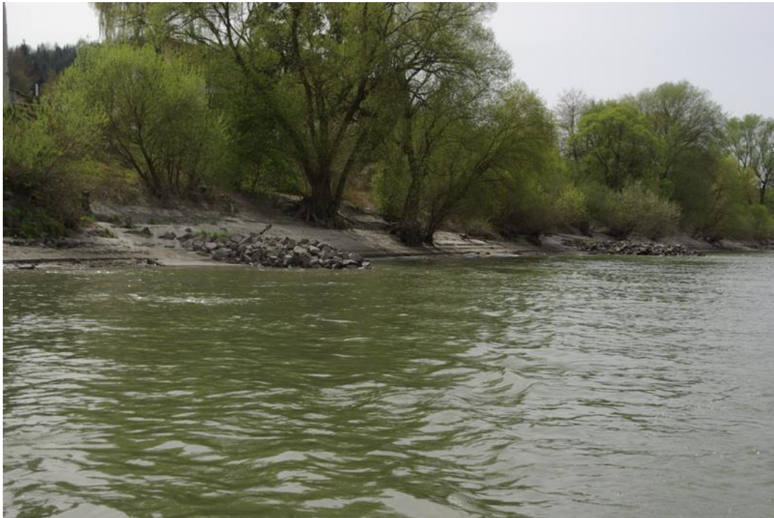
Abbildung 75: Bühnenfeld am rechten Innufer kurz vor der Mündung, gut erkennbar die Feinsedimentablagerung zwischen den Bühnenfeldern, initiiert infolge einer Stauraumspülung während des Hochwassers im Januar 2011.
