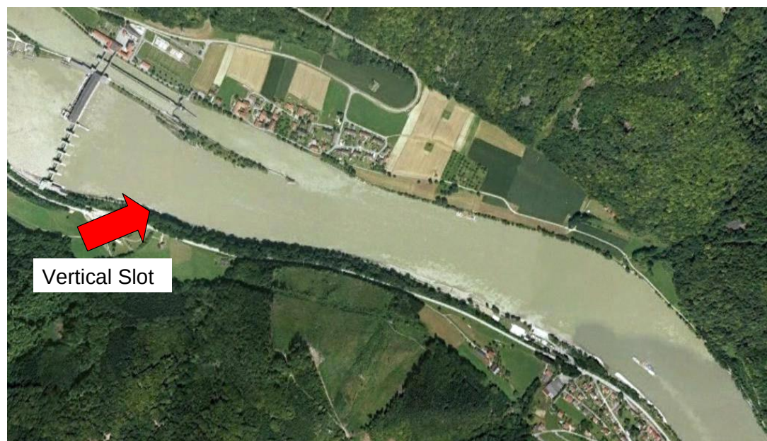
Abbildung 132: Position für Einstieg in technische OWH am rechten Ufer.
