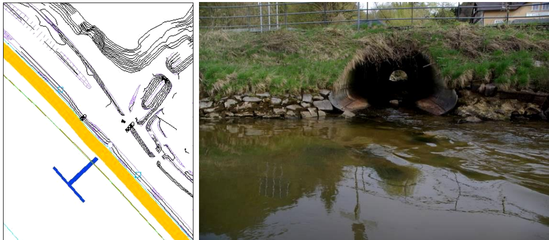
Abbildung 99: Links: Strukturtypen im Bereich der Maßnahme - durchgehende Blockwurfsicherung im Mündungsbereich des Hörreuther Bachs; Rechts: Verrohrter Ab-schnitt im Mündungsbereich
