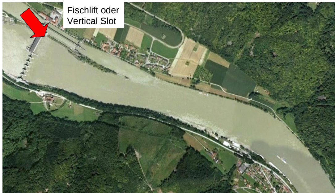
Abbildung 131: Position für Einstieg in technische OWH direkt am Kraftwerk.
