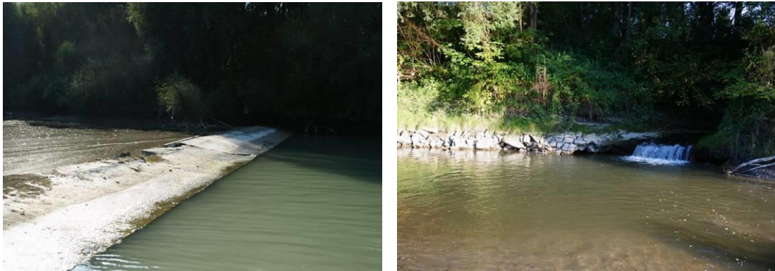
Abbildung 83: Links: Unterbrochene Durchgängigkeit durch eine bestehende Rampe bei Niedrigwasser; Rechts: Mündung des Haibachs in den Lüftenegger Nebenarm – in diesen Bereichen wird als Maßnahme die Wiederherstellung der Durchgängigkeit vorgesehen
