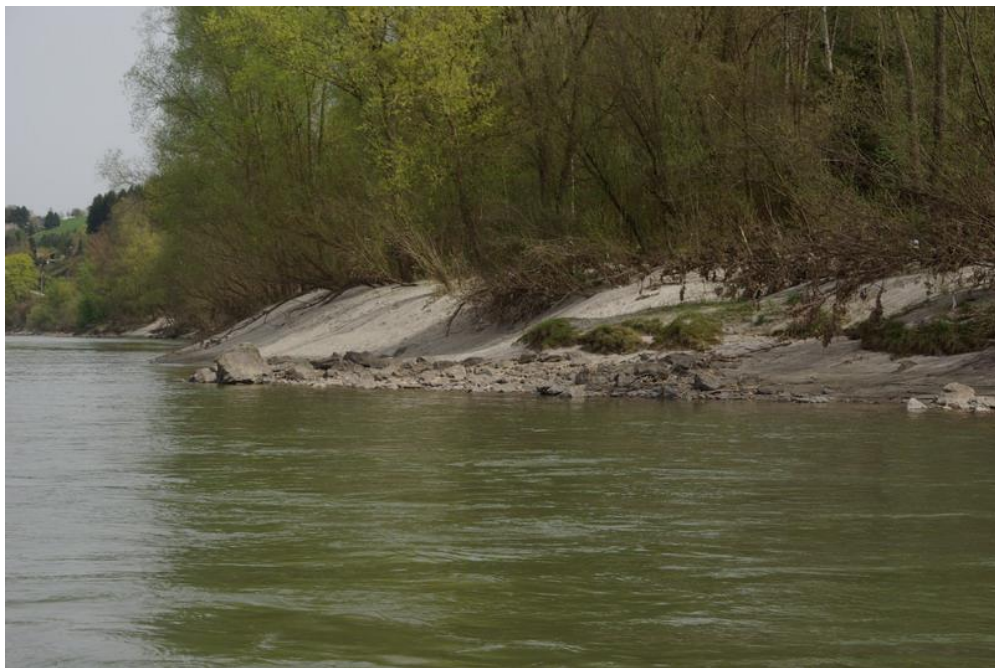
Abbildung 69: Überlagerung des Uferbereichs am rechten Ufer des Inns im Unterwasser des KW Passau-Ingling durch Feinsedimente
