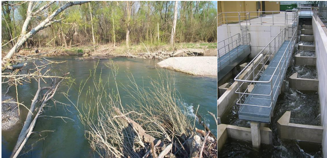
Abbildung 86: Links: Leitbild für dynamischen Umgehungsarm; rechts: Vertical Slot (Schlitzpass).
