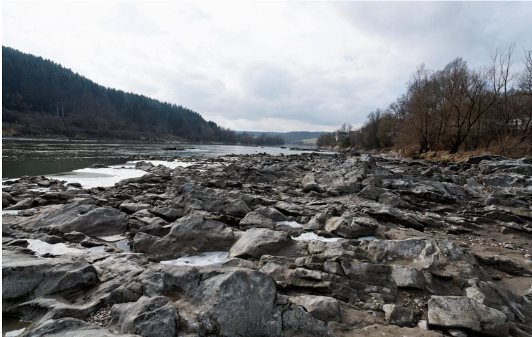
Abbildung 70: Verschlechterung des Ufergradienten im Unterwasser des KWs Passau-Ingling (Aufnahme bei NW)
