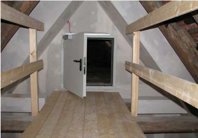
Abb. 12: Brandschutzwand mit Tür, die bei Rauchentwicklung automatisch schließt. (Foto: C. Liegl)
