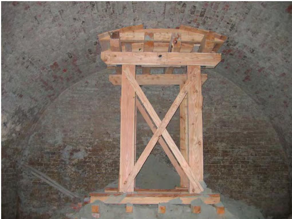
Abb. 8: Stützkonstruktion in Raum B.
