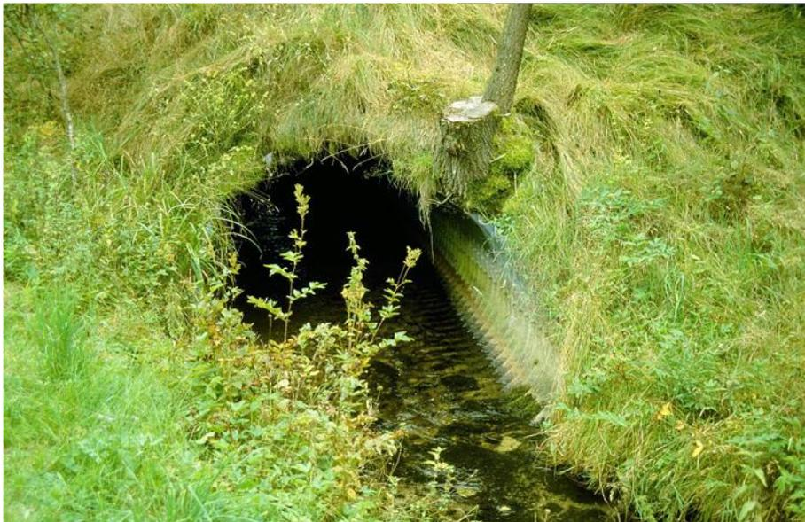
Abb. 12: Enge Rohrdurchlässe (Ranna) wie hier unter der PA 45 bei Haidensäg zwingen den Fischotter bei Hochwasser die Straße zu überqueren.
