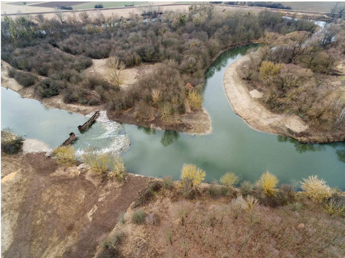
Abb. 109: Abflussaufteilung der Thaya zur dynamischen Dotation des Altlaufes (Foto: TB Zauer GmbH)
