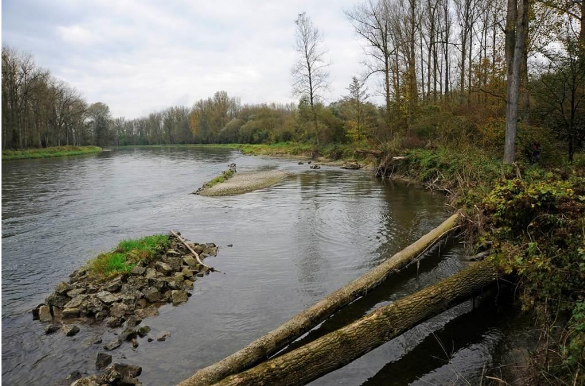
Abb. 114: Im Zuge des Hochwassers 2013 entstandener Uferanbruch bei Isar-km 5,8, Blickrichtung stromauf (Foto: Thomas Herrmann).
