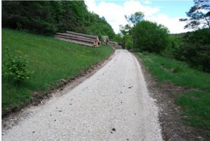
Abbildung 5: Wegebau und Holzlagerung im Bäckertal (Foto: M. Bissinger, 2013)
