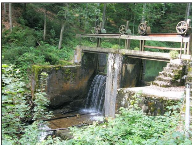
Abb. 7: Beeinträchtigung durch Querbauwerk: Sohlabsturz an der Kleinen Deffernik bei Regenhütte
