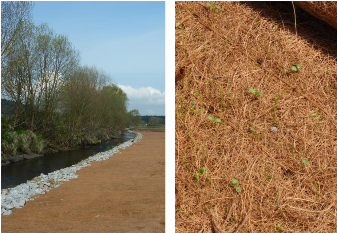
Abb. 19 Entlang eines Muschelgewässers verlegte Kokosmatten im Bereich einer Hochwasserschutzmaßnahme.
