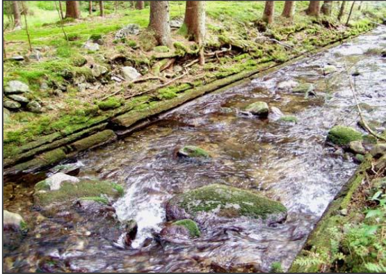
Abb. 94: Abschnitt des Kolbersbaches mit intensiver Längsverbauung
