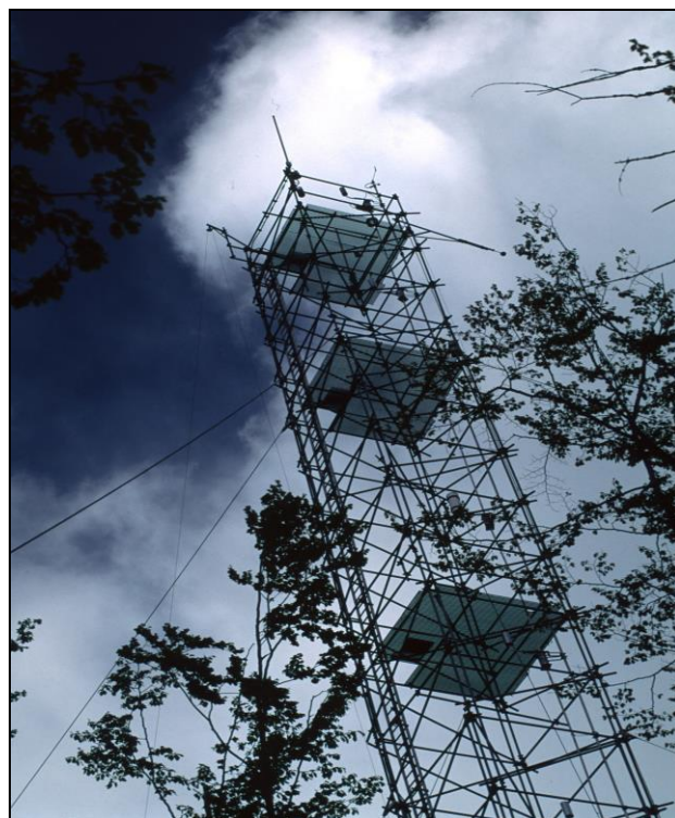
Abb. 18: Messturm Schachtenau (Foto: Kiener, NP BW)
