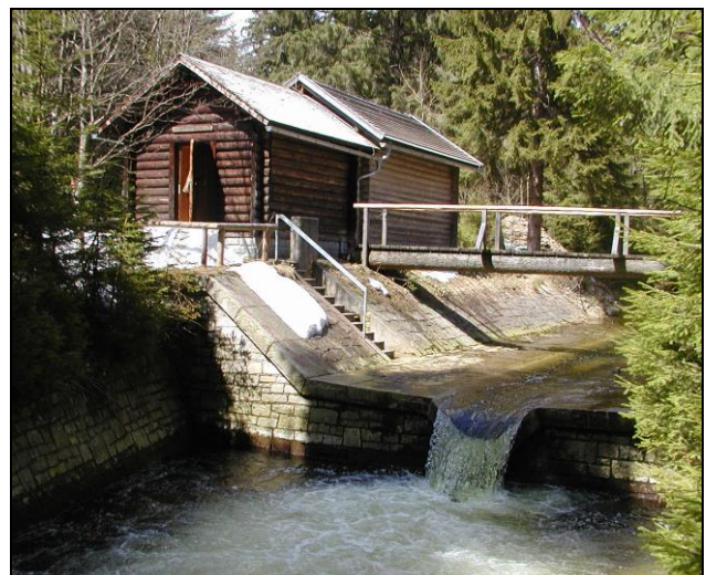
Abb. 24: Hydrologische Messstation „Taferlruck“ an der Großen Ohe (Foto: Pöhlmann, Archiv NP BW)
