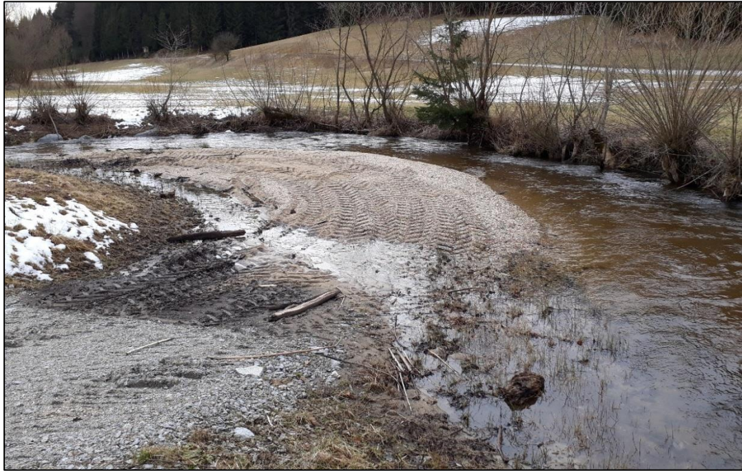
Abb. 11: Umlandabsenkung an der Kleinen Naarn in Oberösterreich
