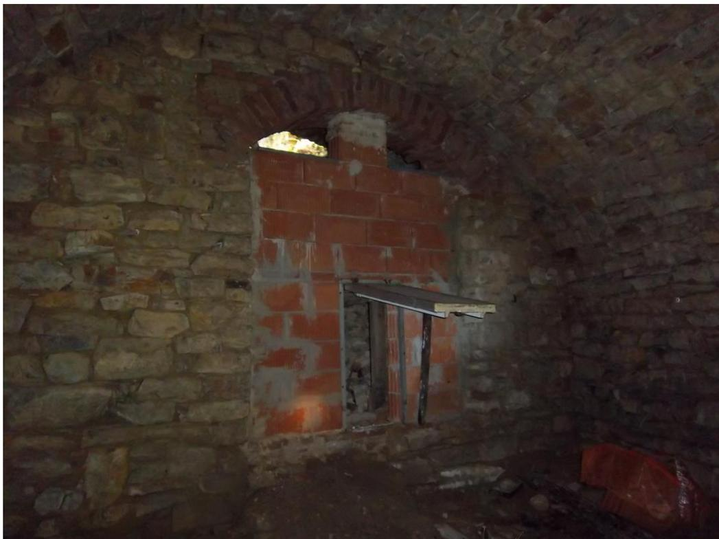
Abb. 41: Vermauerter Torbogen mit Zugangsmöglichkeit für Fledermäuse (Foto: B. Walk)
