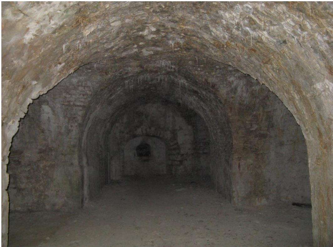
Abb. 17: Gewölbe in der oberen Ebene der Bastion Krebs mit sich bildenden Sinterformen an der Decke (Foto: B. Walk)
