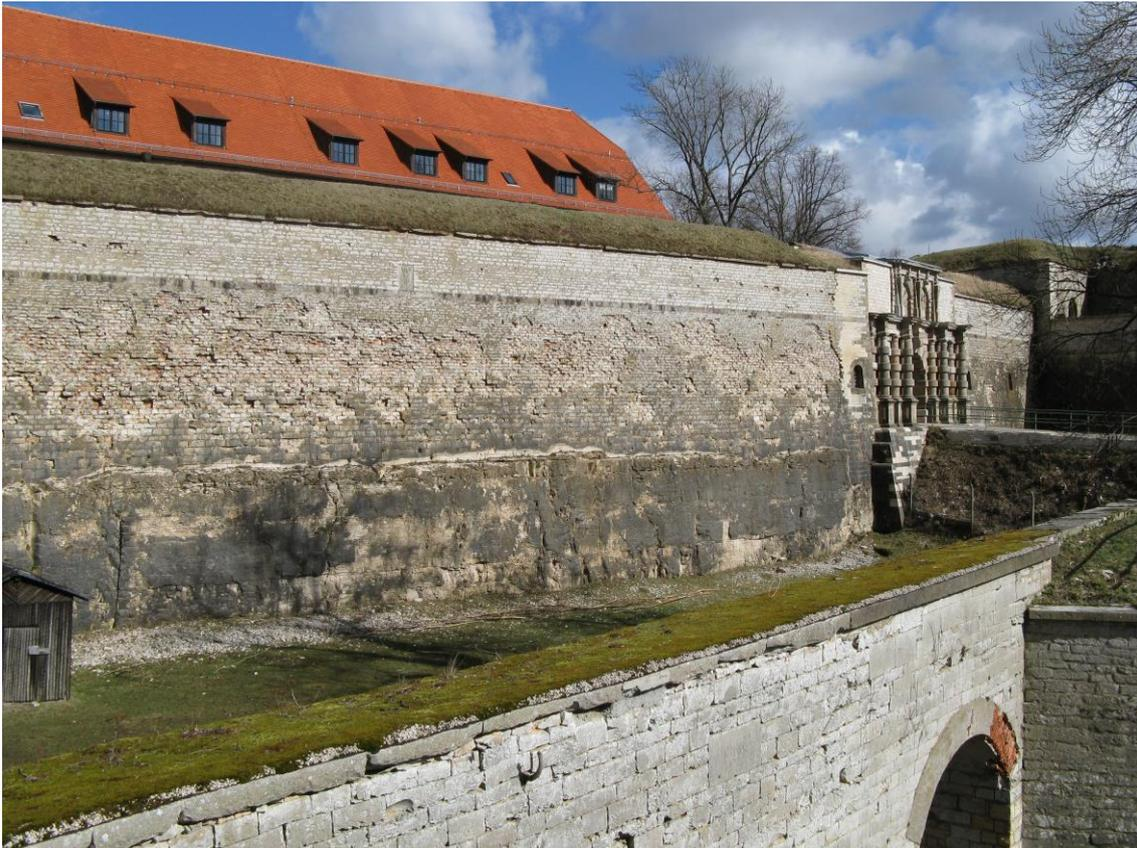
Abb. 18: Ansicht der Außenmauern neben dem Festungsportal. Deutlich erkennbar sind unterschiedliche Erhaltungsstufen der Mauer mit unterschiedlichem Spaltenreichtum (Foto: B. Walk)
