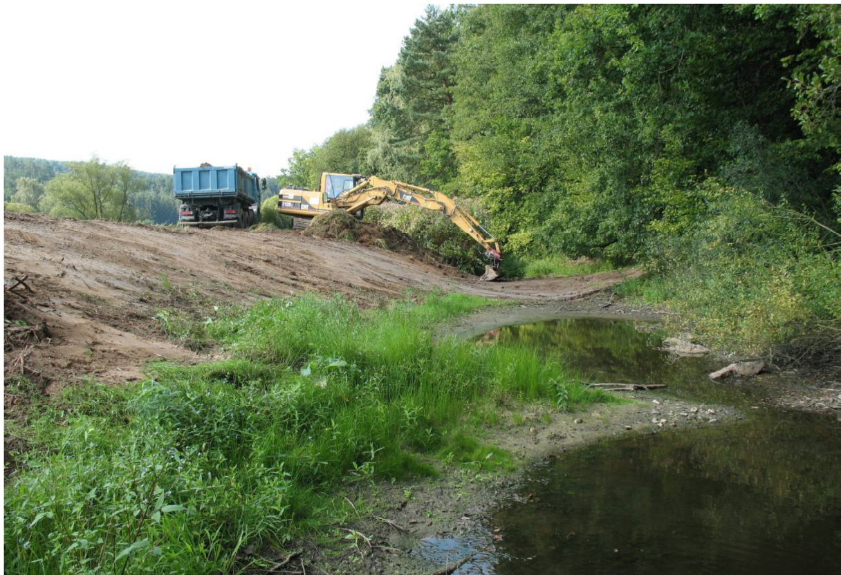
Abbildung 3: Baumaßnahme am Altwasser am Fuß des Gußsteins am 28.08.2007 (Foto: Martin Scheuerer)
