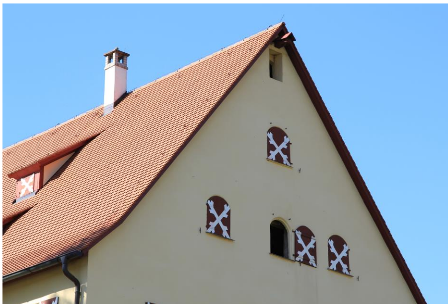
Abb. 10: Ausflugsöffnung am Ostgiebel des Schlosses in Kirchensittenbach (TF 02) (Foto: M. Hammer); früher standen alle drei unteren Fenster offen.
