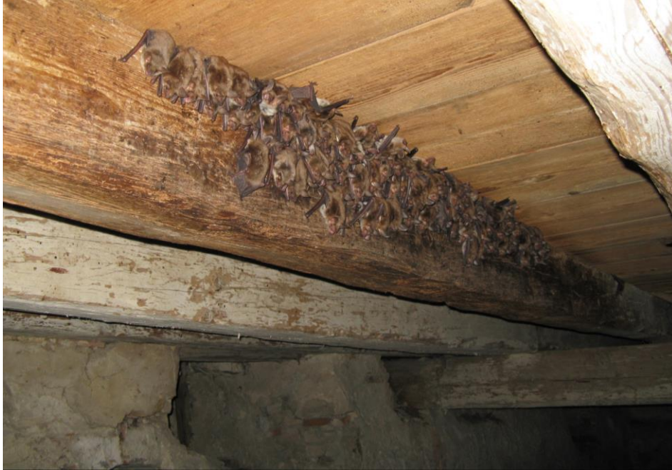
Abb. 19: Hitzehangplatz der Mausohr-Wochenstube im 2. OG des Alten Schulhauses in Obermässing (TF 05) an Balken der Geschossdecke (Foto: B. Walk)
