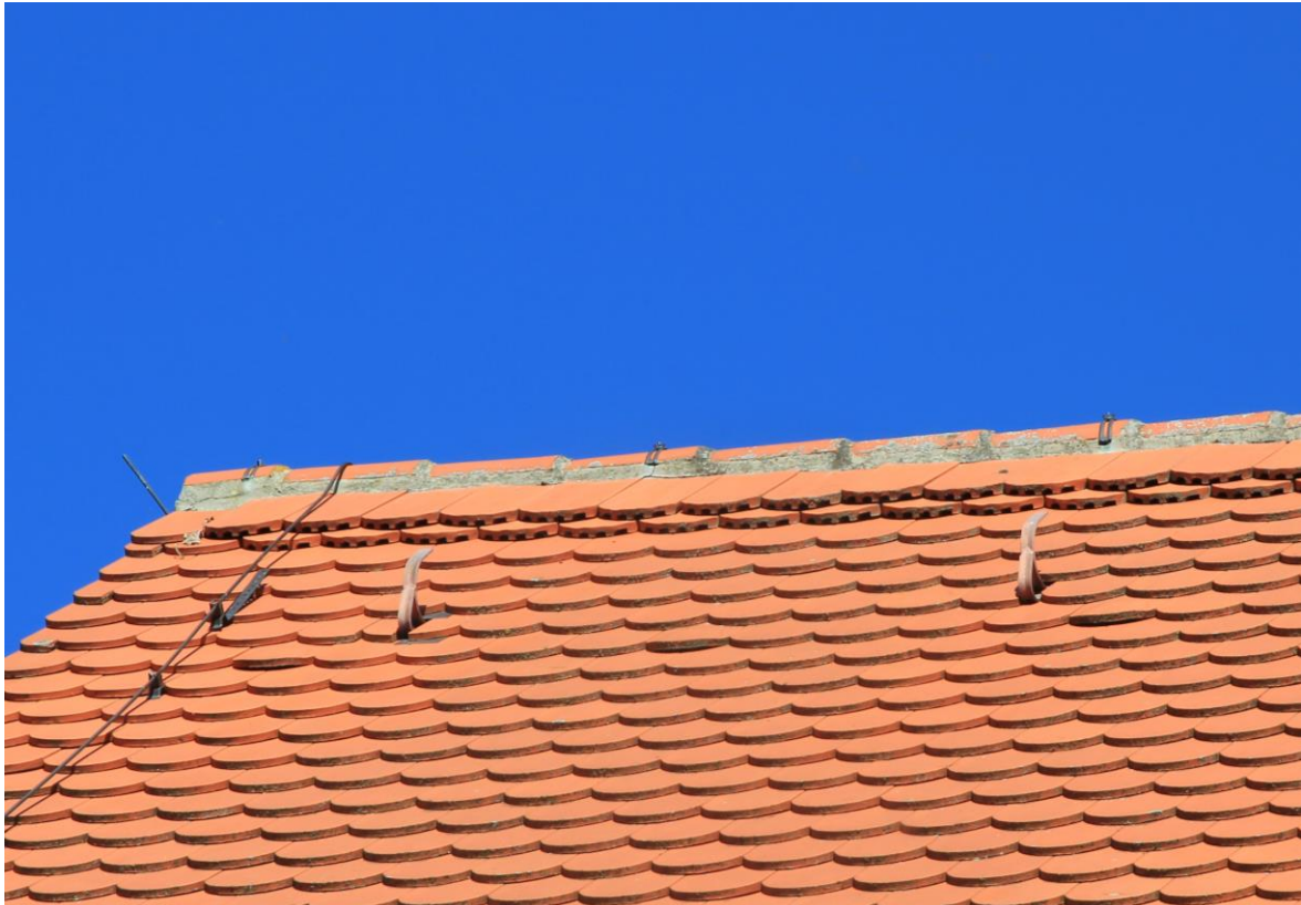
Abb. 16: Deutlich erkennbar sind die zwei Reihen Flächenlüfterziegel unter dem Mörtelfirst der Kirche in Hagenhausen (Zustand nach Renovierung) (Foto: M. Hammer)
