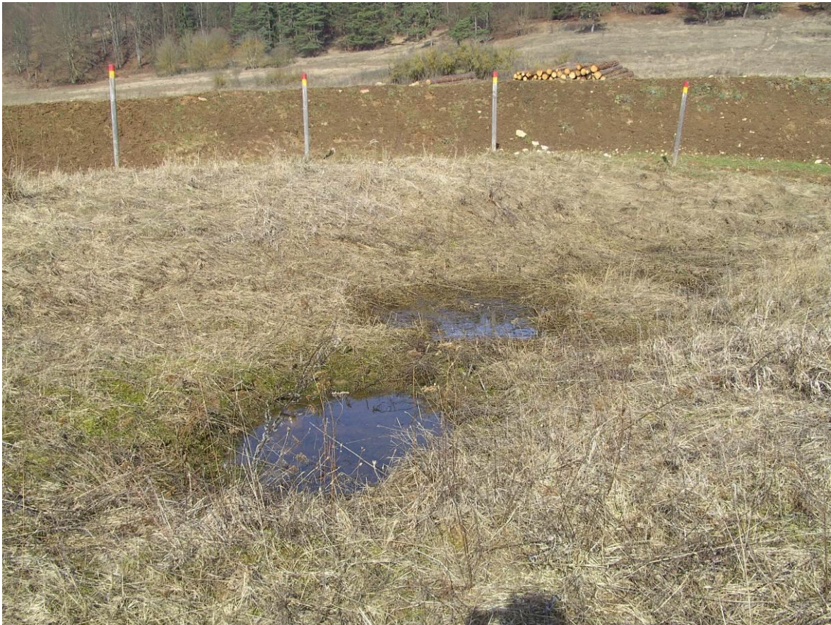
Abb. 3: Mit Absperrpfosten und Wall gesicherte Doline bei Breitenwinn
