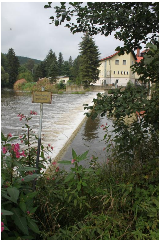
Abb. 13: Oft zu sehen: Triebwerksanlagen, die häufig nicht durchgängig sind wie hier in Altendorf (Foto: Pichlmaier).
