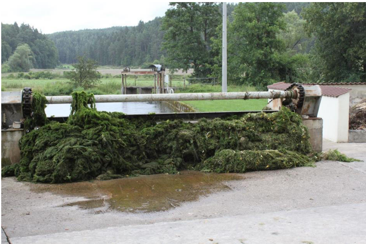
Abb. 81: Das massenweise Auftreten der Algenart Chladophora rivularis erfordert eine regelmäßige Rechenreinigung an den meisten Wasserkraftwerken an der Lauterach, hier an der Schwarzmühle im Sommer 2010 (Bild: Dr. Ring).
