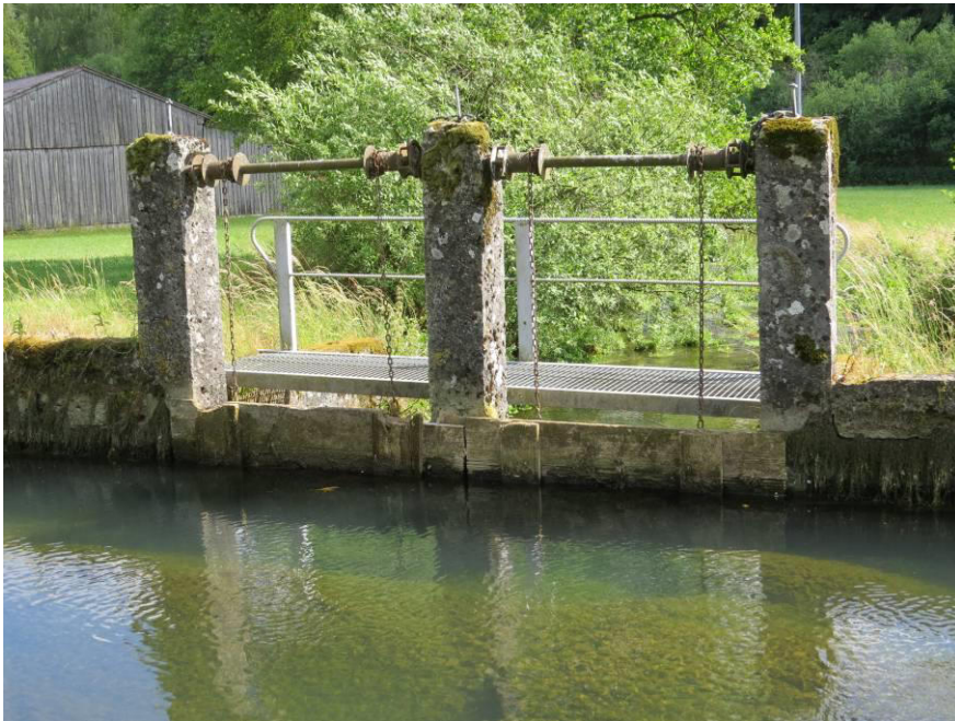
Abb. 3: Gewässerverbauung mit Wehr im Bereich des Mühlgrabens von Pattershofen.
