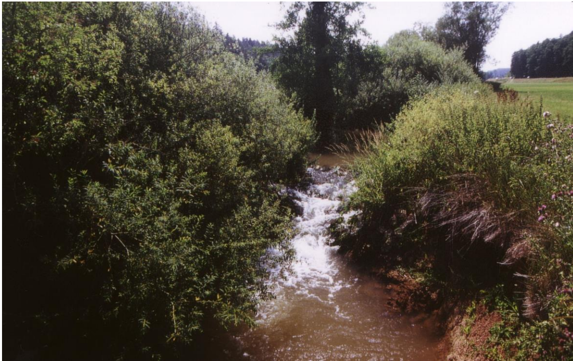
Abbildung 4: Eine Sohlschwelle am Haselbach mit dichtem Ufergebüsch.
