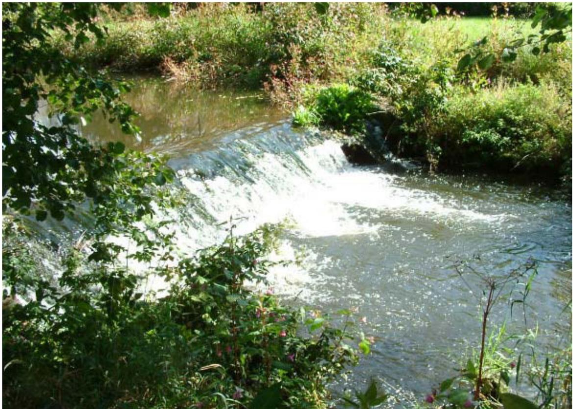
Abb. 16: Oberes Ende des befischten Abschnitts für das Monitoring zur Wasserrahmenrichtlinie (Pfreimd bei Kainzmühle). Hier deutlich erkennbare und für viele Fischarten, speziell für den Schwachschwimmer Koppe, nicht überwindbare Querverbauungen (Sohlschwelle). (Foto: Dr. Ring)
