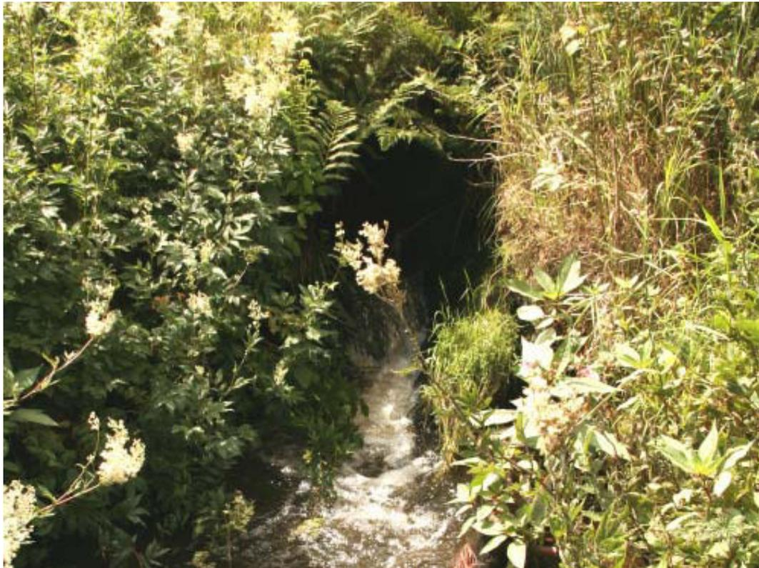
Abb. 15: Es ist keine Durchgängigkeit (speziell für die Koppe) an den vorhandenen Rohrdurchlässen gegeben. (Foto: Dr. Ring)
