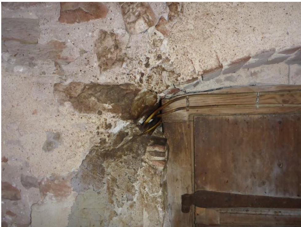
Abb. 18: Kirche in Duggendorf (TF 05): Durchschlupf zwischen Kirchturm und Chor entlang eines Kabelschachtes neben dem Türstock. (Foto: B. Walk)
