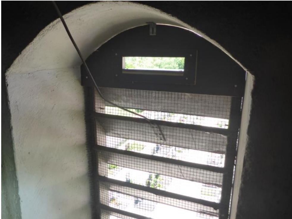
Abb. 46: Nach Norden exponierte Schallluke mit Ausflugsöffnung in der Kirche in Sinzing (TF 12). (Foto: B. Walk)
