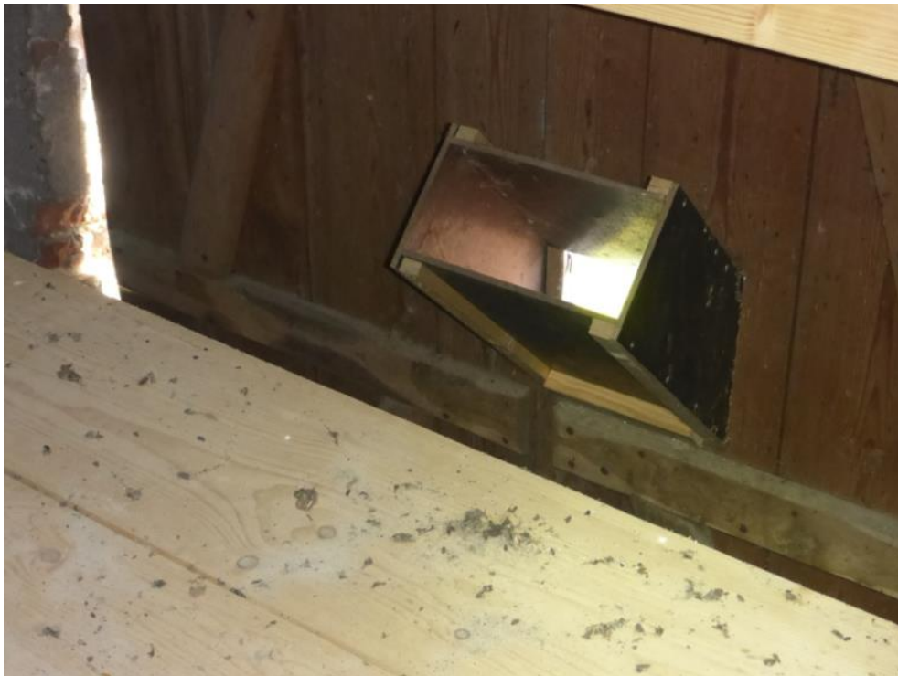
Abb. 34: Neu geschaffene Ausflugsöffnung in der Klosterkirche in Pielenhofen (TF 09) im nördlichen Kirchturm. (Foto: B. Walk)
