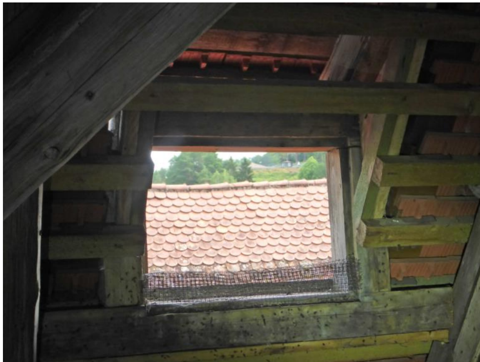
Abb. 13: Ausflugsöffnung an der Nordseite des Chores der Kirche in Hohenburg (TF 04) mit dem nach unten abgerollten Drahtgitter. (Foto: B. Walk)
