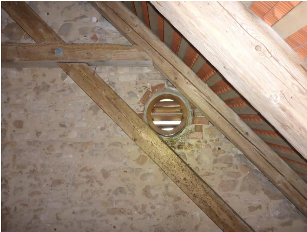
Abb. 16: Eine von zwei baugleichen Ausflugsöffnungen am Westgiebel der Kirche in Dugendorf (TF 05). (Foto: B. Walk)
