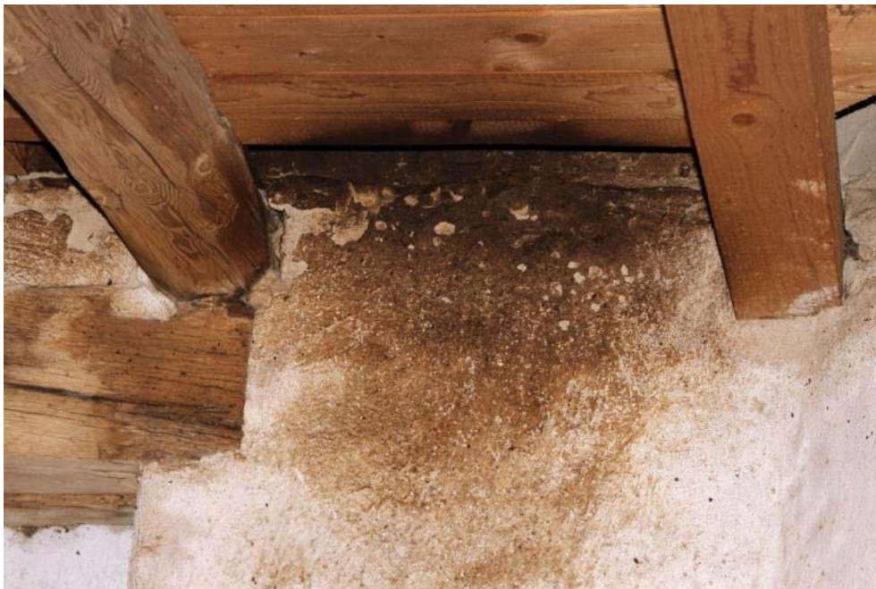
Abb. 26: In der Kirche von Staadorf (TF 07) gelangen die Mausohren von ihrem Hangplatz in der Turmzwiebel durch einen engen Durchschlupf an der Wand in die unteren Etagen des Kirchturmes und zu ihrer Ausflugsöffnung. (Foto: M. Hammer)
