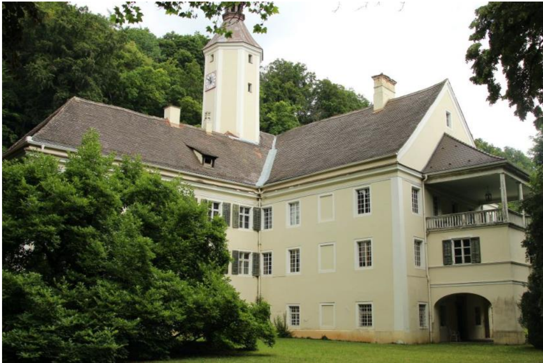
Abb. 37: Schloss Etterzhausen (TF 10): Ansicht von der Gartenseite: Die Tiere nutzen die Dächer des südlichen (links) und östlichen Flügels (rechts). Hauptausflugsöffnung ist die kleine Schleppgaube im Südflügel. (Foto: M. Hammer)
