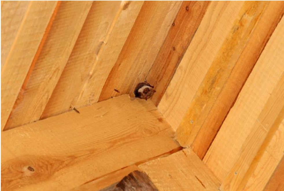
Abb. 20: Seit der Sanierung 2010 bis 2012 wird der ursprüngliche Hangplatz im Konventgebäude von Kloster Plankstetten (TF 06) nur noch von Mausohr-Einzeltieren genutzt. (Foto: M. Hammer)
