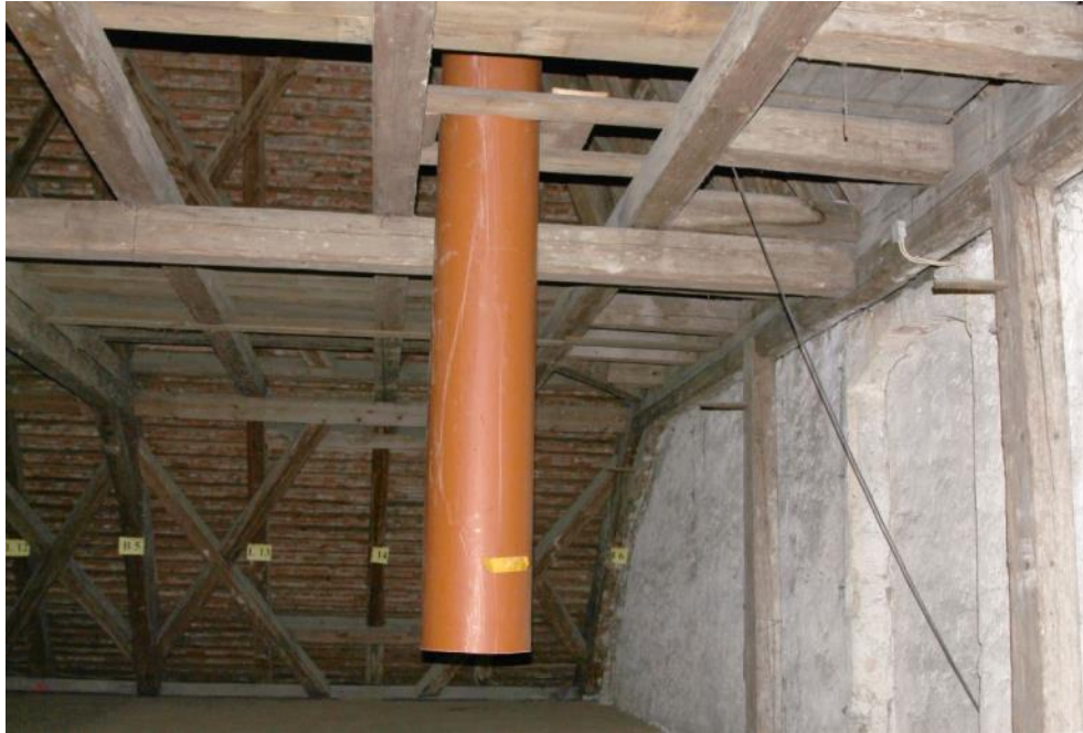
Abb. 44: Kunststoffrohr zur erleichterten Entsorgung des Mausohrkotes im Hauptgebäude des Gutshof Etterzhausen (TF 11). (Foto M. Hammer)
