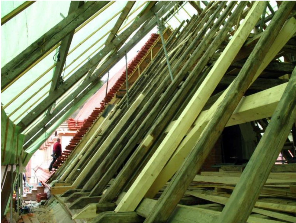
Abb. 23: Anfang April 2012 waren die Arbeiten am ursprünglichen Quartier im Kloster Plankstetten (TF 06) noch in vollem Gang. (Foto: M. Hammer)
