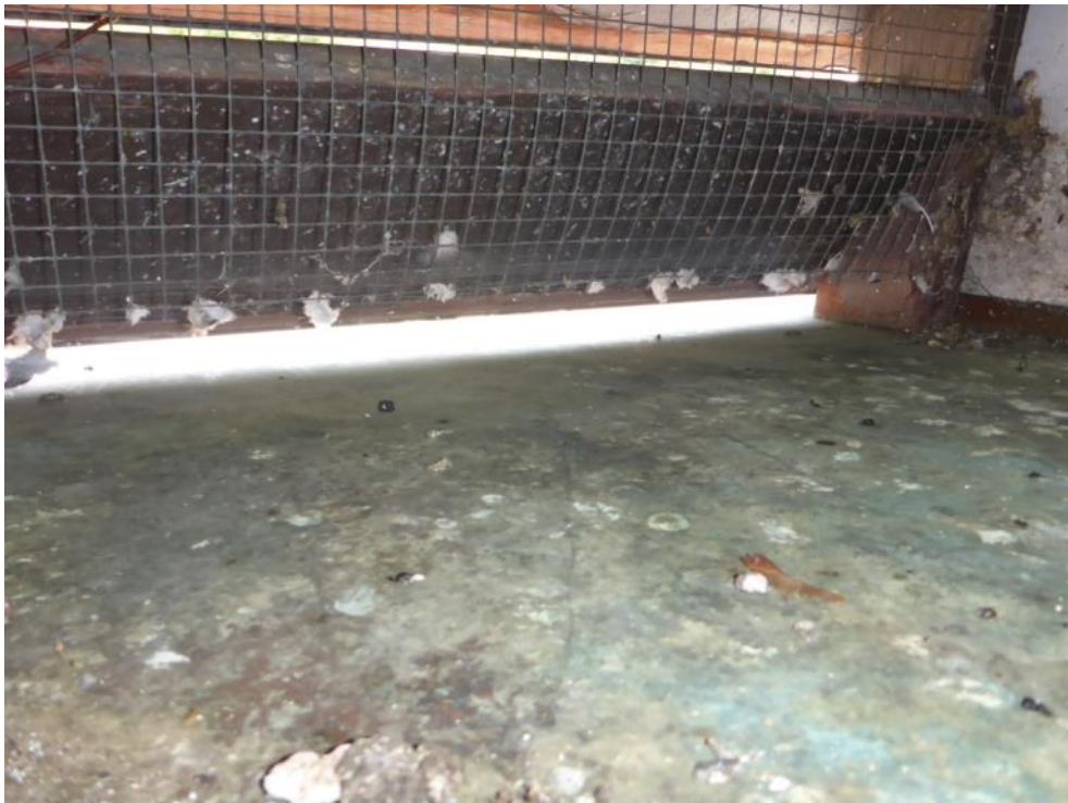
Abb. 47: Unter der vergitterten Schallluke verbliebener Spalt in der Kirche in Sinzing (TF 12). (Foto: B. Walk)
