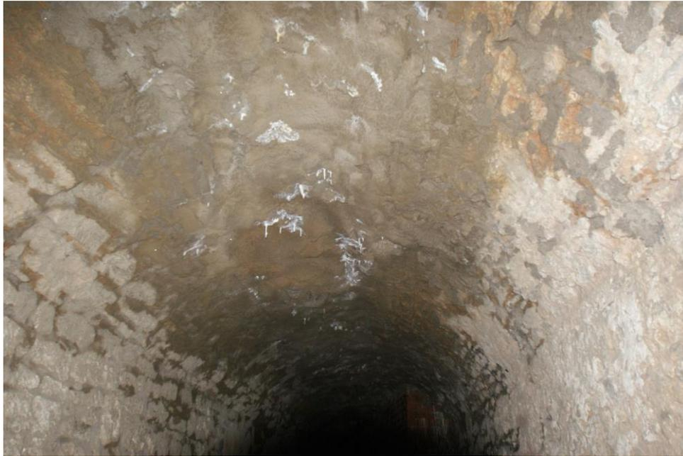
Deckensicherung mit Spritzbeton
