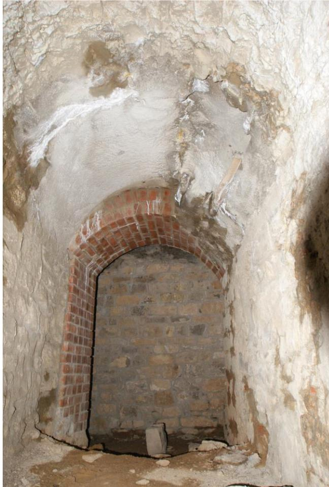
Verlust von Hangplätzen durch Klinkervermauerungen und Verschluss der Spalten
