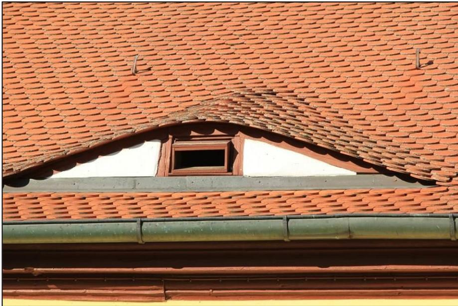
Abb. 24: Zusätzlich geschaffene Ein- und Ausflugsöffnung in einer Gaube des Rathauses in Ipsheim (Foto M. Hammer)
